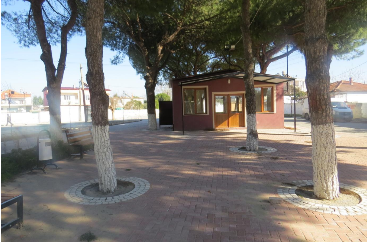
Kafeterya ve çevre düzenlemesi çalışmalarının ardından görünümü
