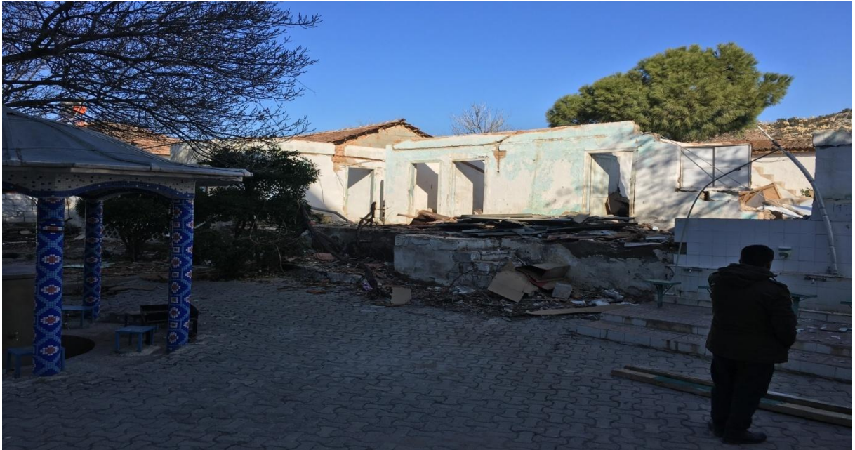
Çullugörece Mahallesi Camii çalışmalarının başlanılmasının ardından görünüm
