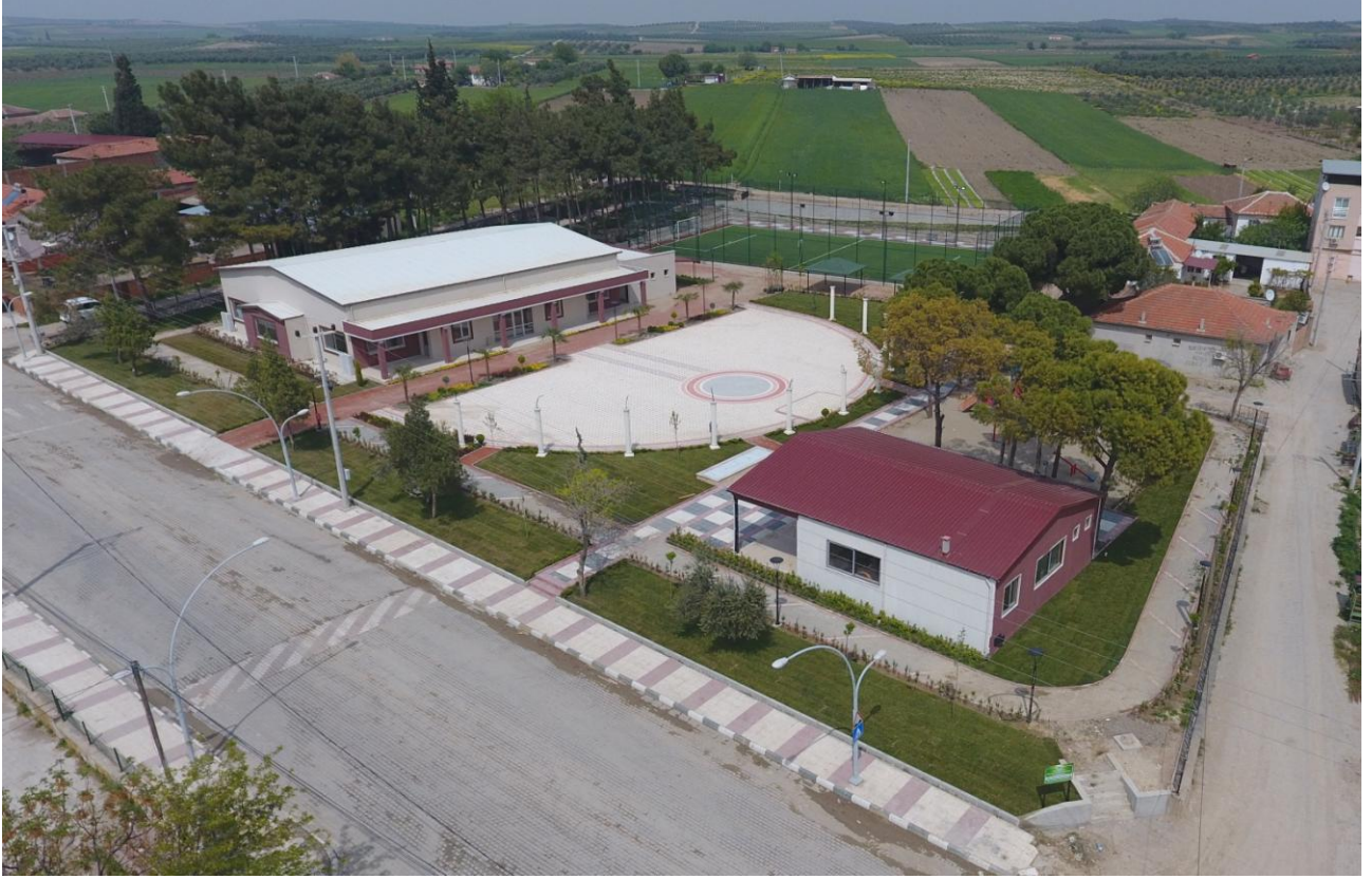
Koldere Mahallesi rekreasyon alanı çalışmalarının görünümü
