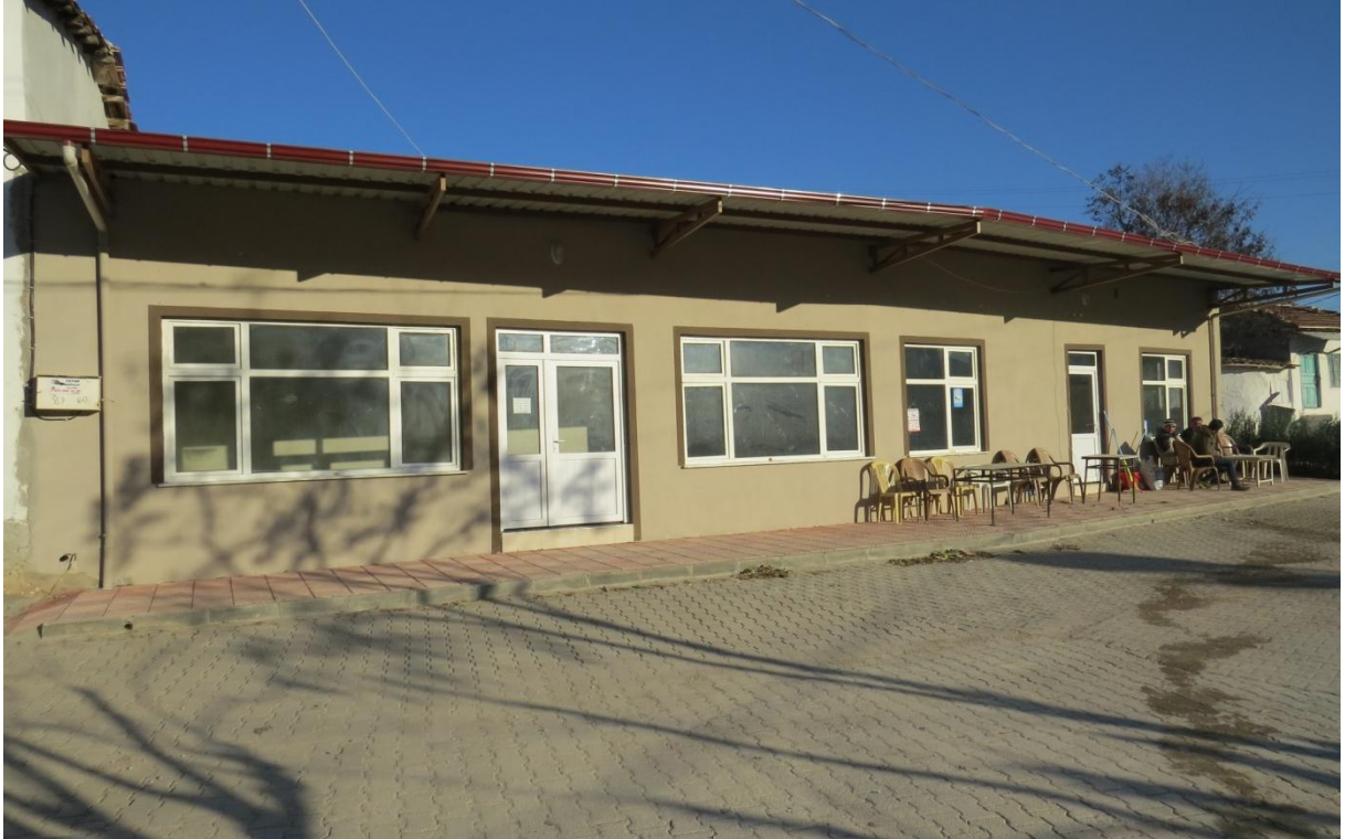
Seyitoba Mahallesi kahvehane ve dükkan inşaatının tamamlanmasının ardından görünüm
