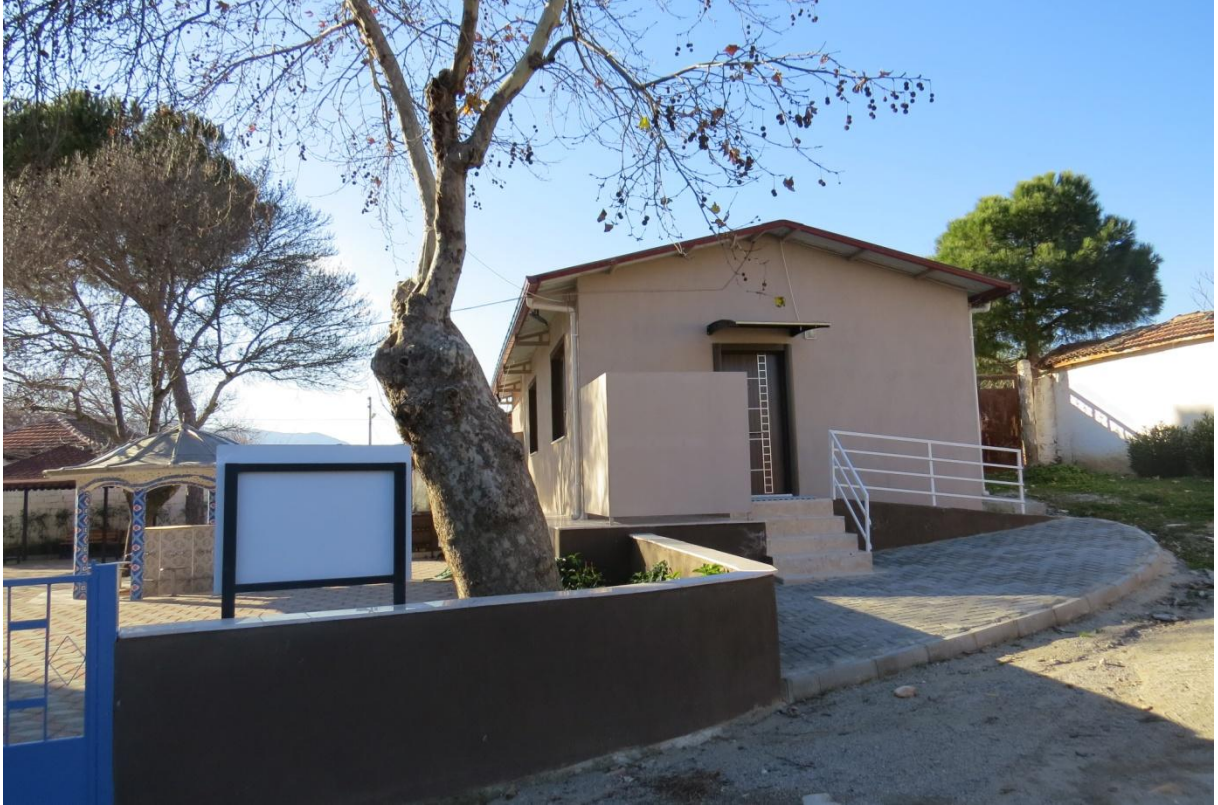
Çullugörece Mahallesi Camii çalışmalarının tamamlanmasının ardından görünümü
