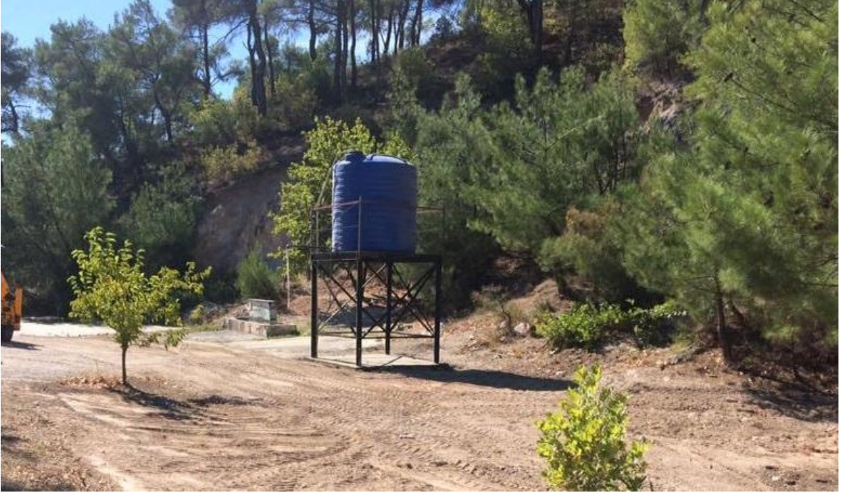
Şatırlar Mahallesi tarımsal sulama tesisi görünümü
