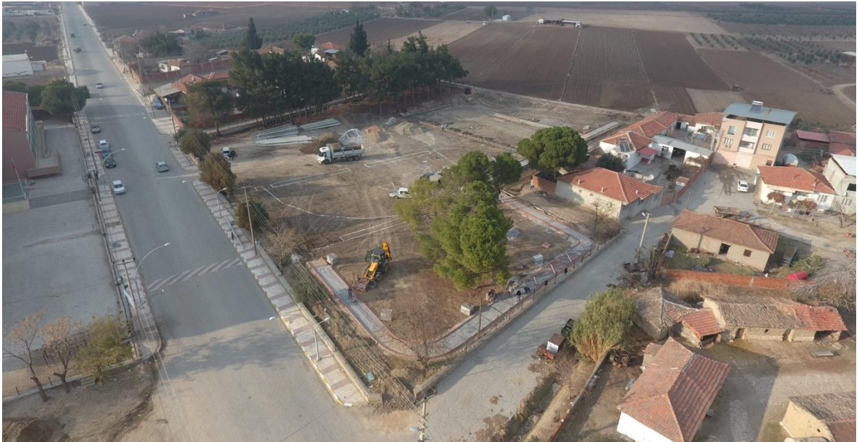
Koldere Mahallesi rekreasyon alanı çalışmaları başlamadan önce görünüm
