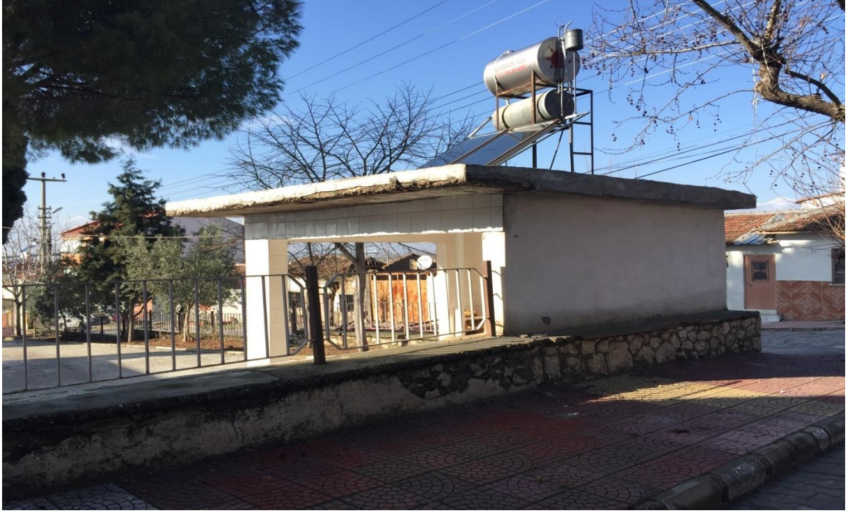
Koldere Mahallesi Göçmen Camii çalışmaların başlamadan önceki görünümü
