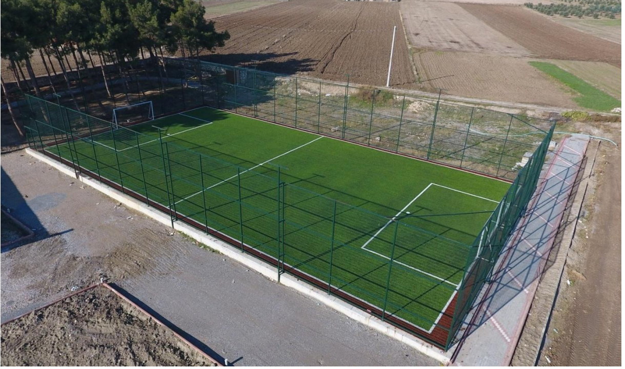
Koldere Mahallesi rekreasyon alanı kapsamında yapılan halı sahanın yapımından sonraki görünümü
