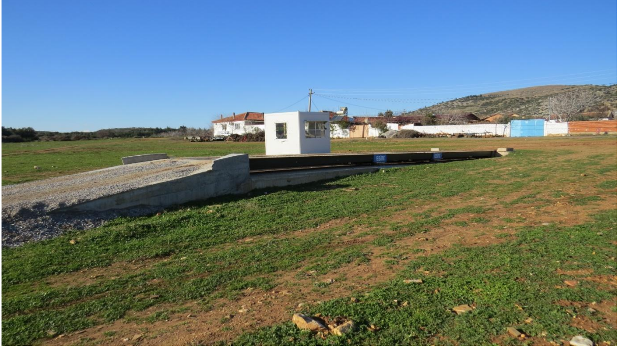
Çullugörece Mahallesi'nde ki 60 tonluk kantarın kurulumundan sonraki görünümü
