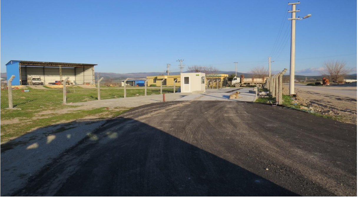
Paşaköy Mahallesi 60 tonluk kantarın kurulumundan sonraki görünümü
