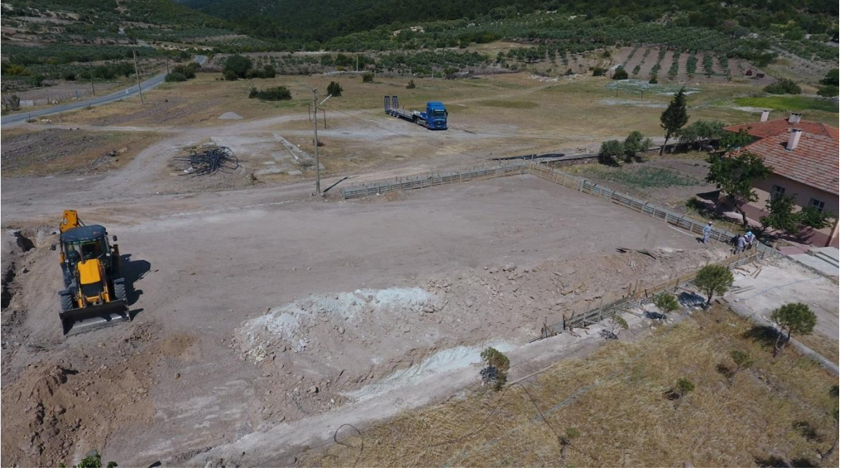
Hatıplar Mahallesi halı saha çalışmalarının başlamadan önceki görünümü
