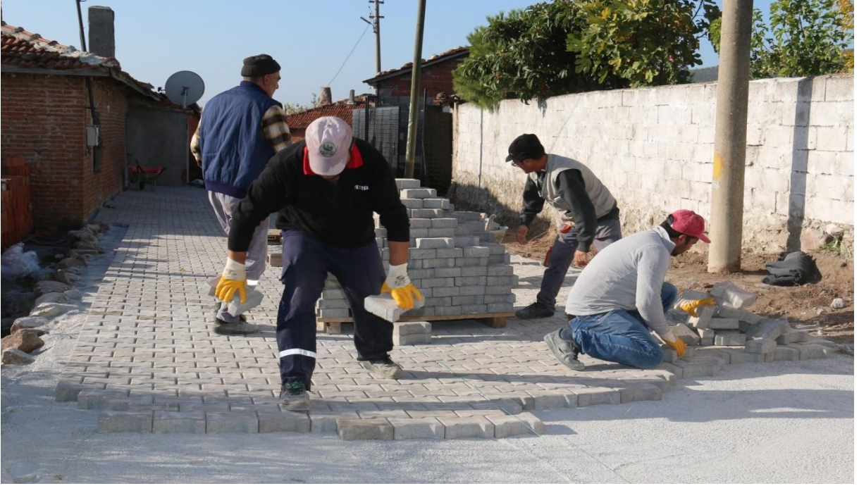
Çaltepe Mahallesi taş döşeme çalışmaları
