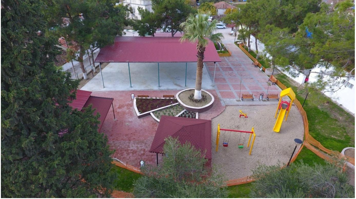
Kepenekli Mahallesi çalışmaların tamamlanmasının ardından görünümü
