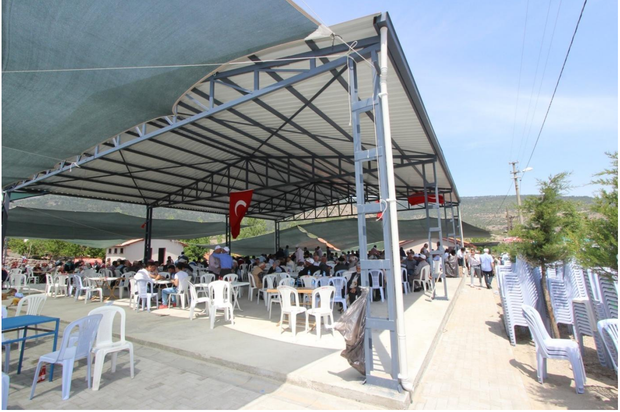
Aydınlar yarı kapalı hayır yeri çalışmalarının tamamlanmasının ardından görünümü
