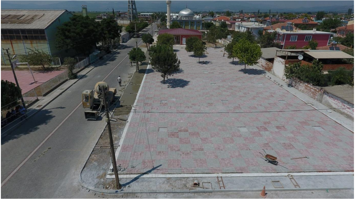
İlçemiz Kurtuluş Mahallesi Taziye evi çalışmalarının tamamlanmasının ardından görünüm
