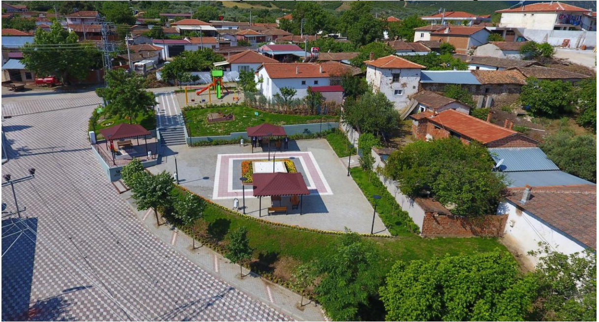
Heybeli Mahallesi meydan çalışmalarının tamamlanmasından sonraki görünümü
