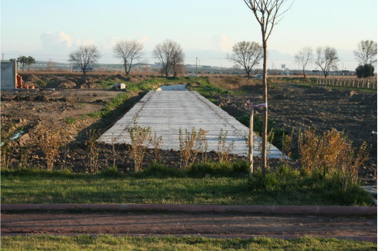
Sosyal aktivite merkezinde ilave olarak kapatılan ve zemini betonlanan T11 tahliye kanalı görünüşü
