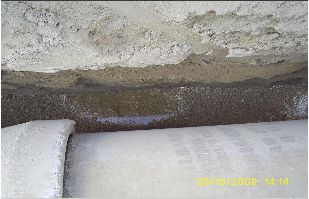
Ana Kolektörde \varnothing 800 mm. Çapında B.A.Boru Hendek içindeki Yataklama ve Döşeme Tamamlandıktan sonra Gömlekleme yapılmadan önceki Görünümü.
