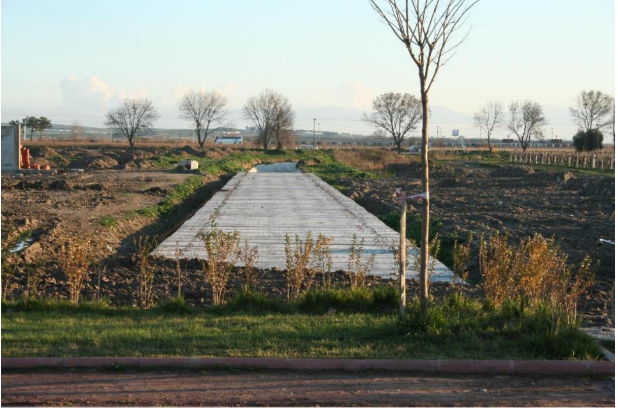
Çift-Te elemanla kapatılması
