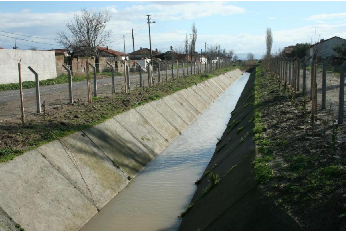
Atatürk Mahallesi Y 11 Kanalından Bir Görünüş.
