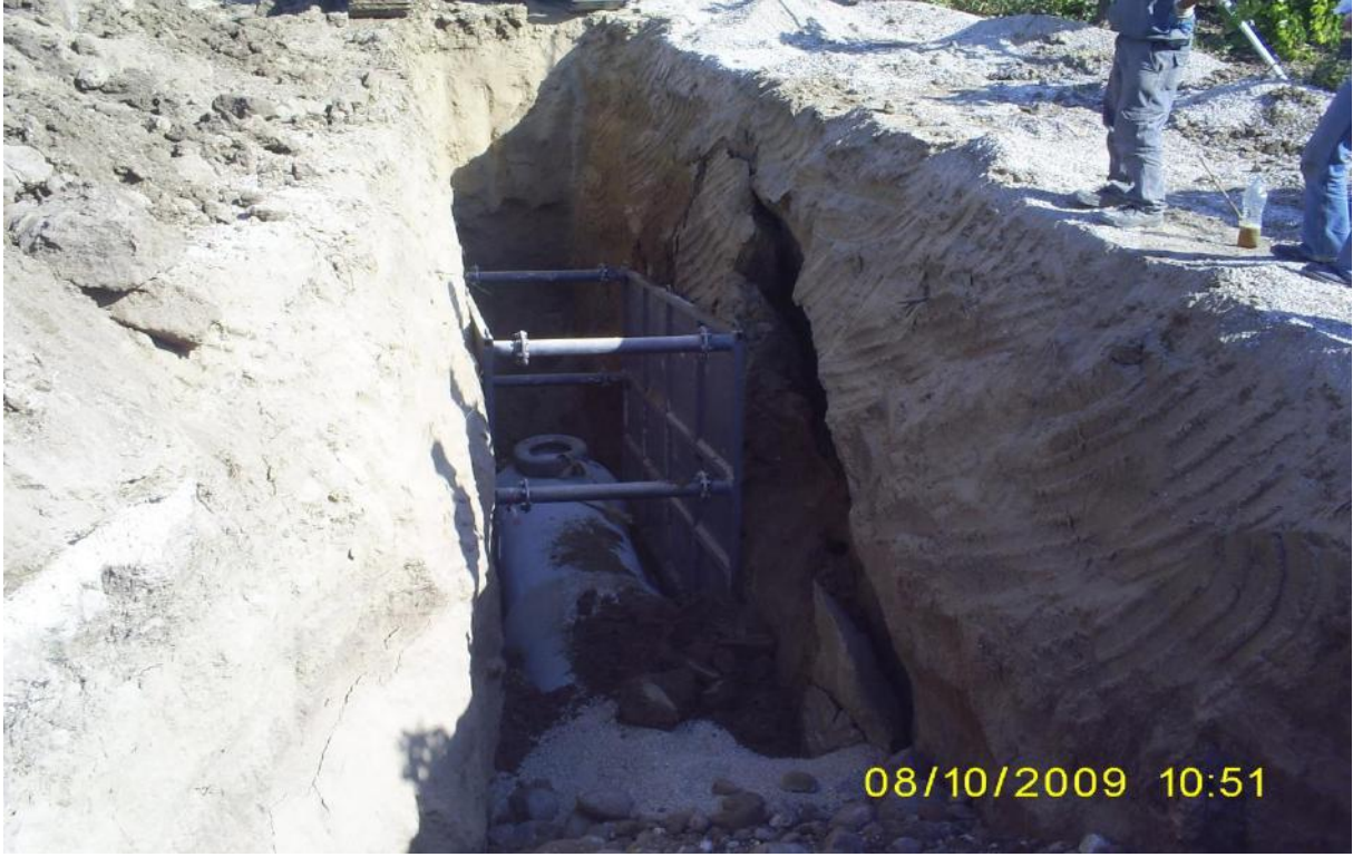
Ana Kolektörde Hendek İçine Yerleştirilmiş Çelik Pano
