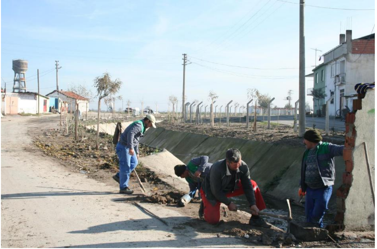
Saruhan Mahallesi Toprak olan T11 Kanalı Islahı, Betonlama ve Çit İle Çevrilerek Yeşillendirme Çalışmaları Sırasında.
