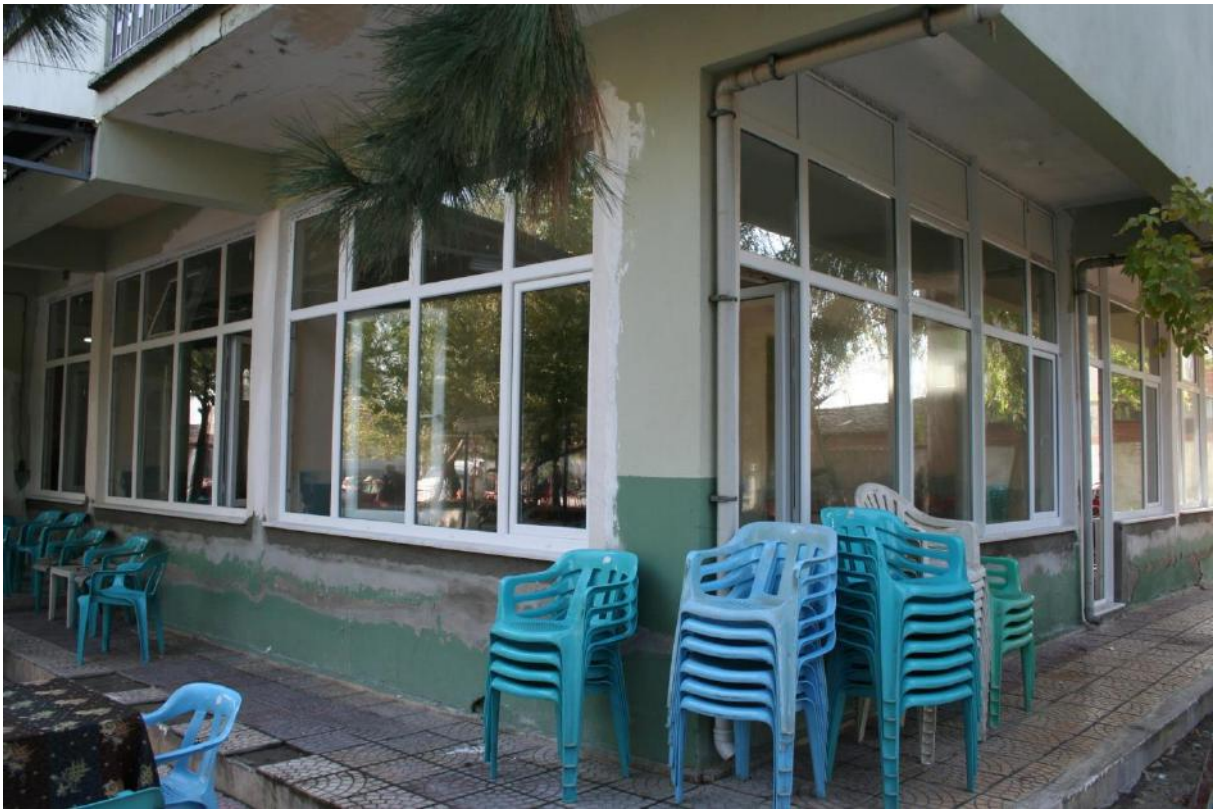
Yılmaz Kahveleri Kahvehane Cephe Tadilatı Yılmaz Mahallesi mülkiyeti Belediyemize ait olan Kışlık Düğün Salonu ile Yılmaz meydanındaki iki katlı sosyal tesis dış cephe tadilatları yapılarak cephelerden boyama yapılmıştır.
