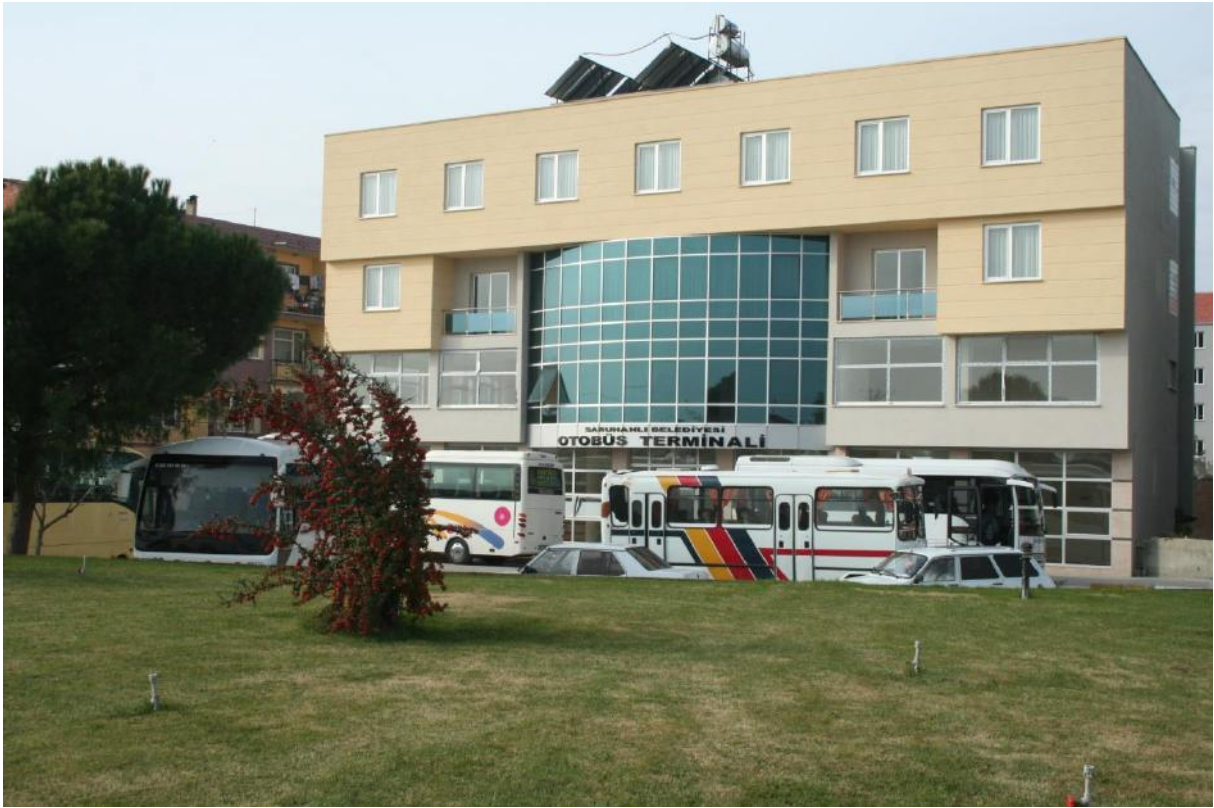
Anayol Üzerinden Otel ve Terminal Binasının Görünüşü
