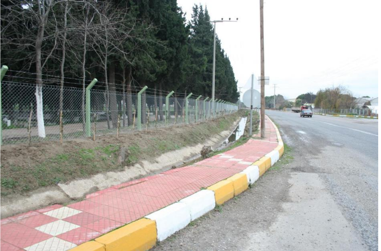
Merkez Mezarlığı Kumçay Caddesi cephesi yeşillendirme ve çit yapımı.
