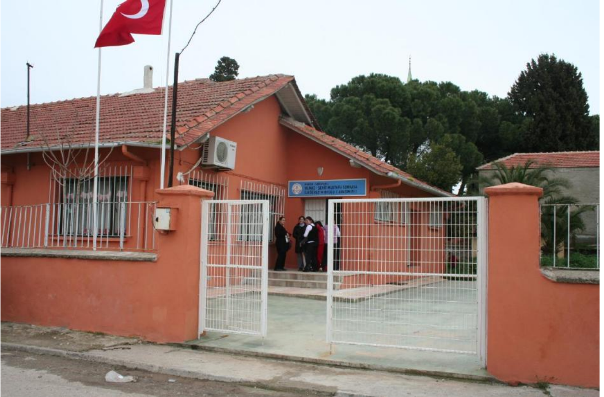
Yılmaz Şehit Mustafa Sonkaya İlköğretim Okulu Anaokul Binası
