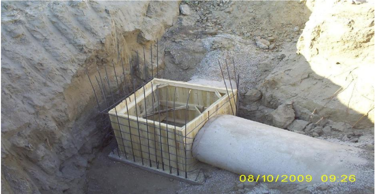
Ana Kolektörde Yerinde Yapılarak Hazır Beton İle Üretilecek Olan Muayene Bacasının İç Kalıp Hazırlama Çalışmalarından Görünüş.
