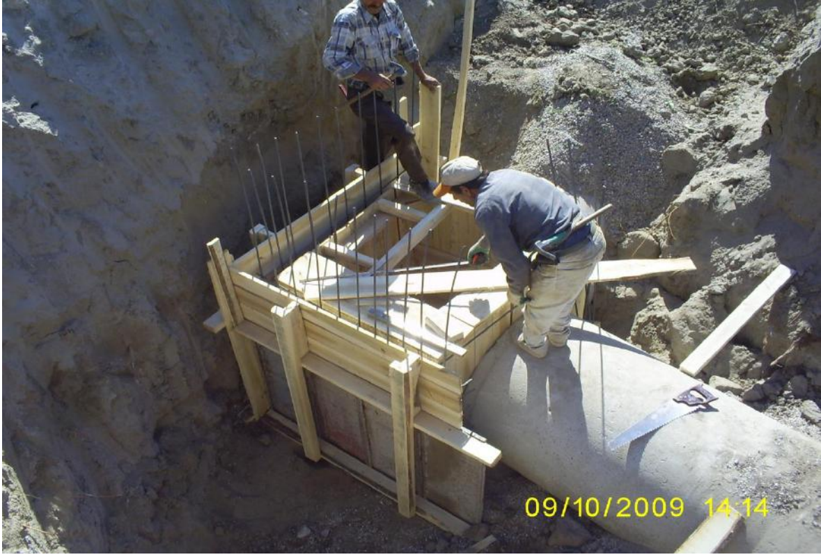
Ana Kolektörde Yerinde Kalıp Yapılarak Hazır Beton İle Üretilecek Olan Muayene Bacasının Dış Kalıp Hazırlama Çalışmalarından Görünüş.(Pagmat İplik Fabrikası Yolu D.S.İ.Tahliye kanalı Köprü Yanı)
