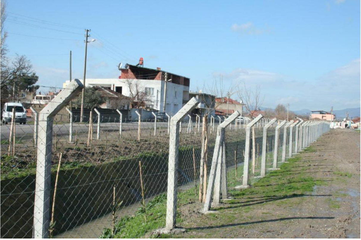
Saruhan Mahallesi T 11 Tahliye Kanalı Islah Çalışmasından sonraki Görünüşü.
