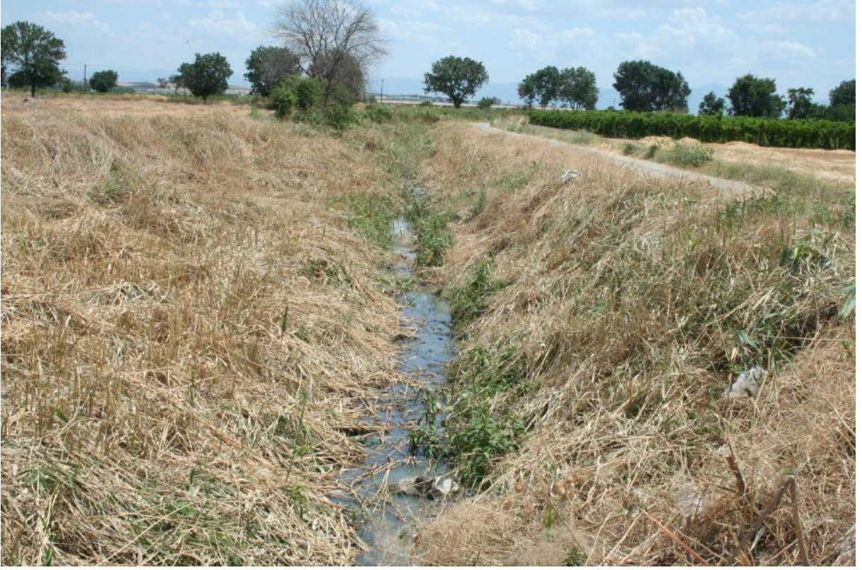
T11 tahliye kanalının eski hali
