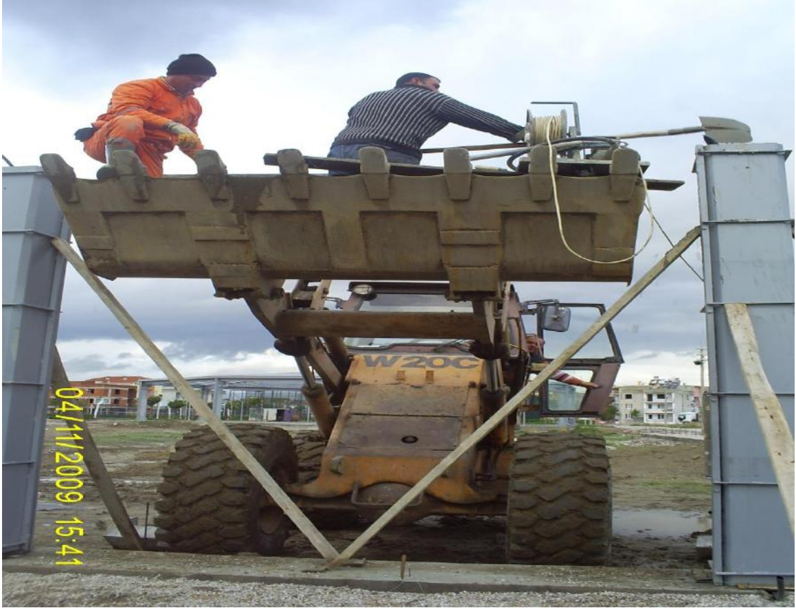
Sosyal Aktivite Merkezi Yüzme Havuzu Çevresi İhata Duvarı Yapılması
