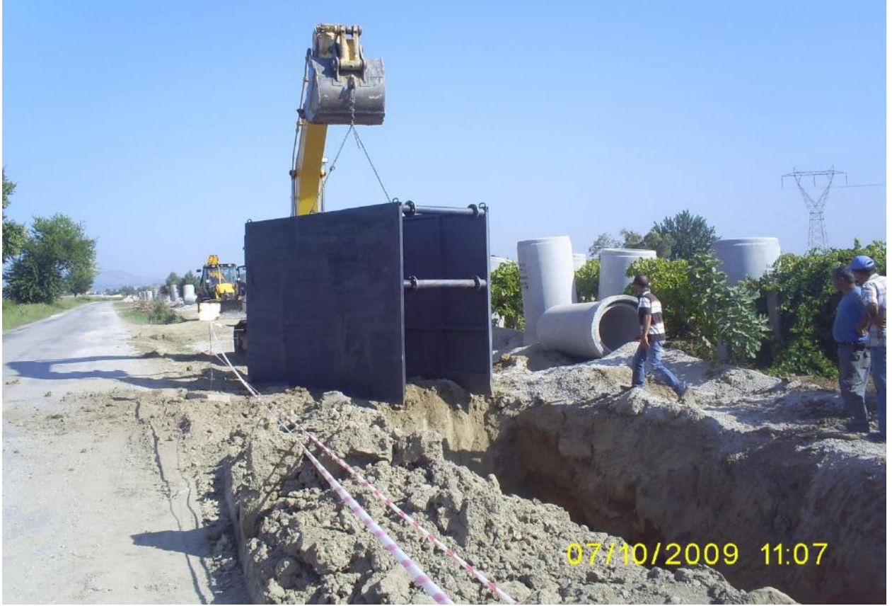
Ana Kolektörde İplik Yolunda Arıtma –Yılmaz Mezarlığı Arasında Çelik Pano İksalı Kazı Çalışması
