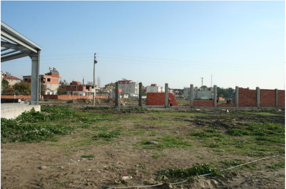
Ayrıca bu kısımda yapılacak olan Yarı Olimpik Şeklindeki Yüzme Havuzunun çevre İhata duvarının yarıya yakın kısmı bitirilmiştir.2010 yılı içerisinde Çok amaçlı salonun Müştemilat eklenti binası
