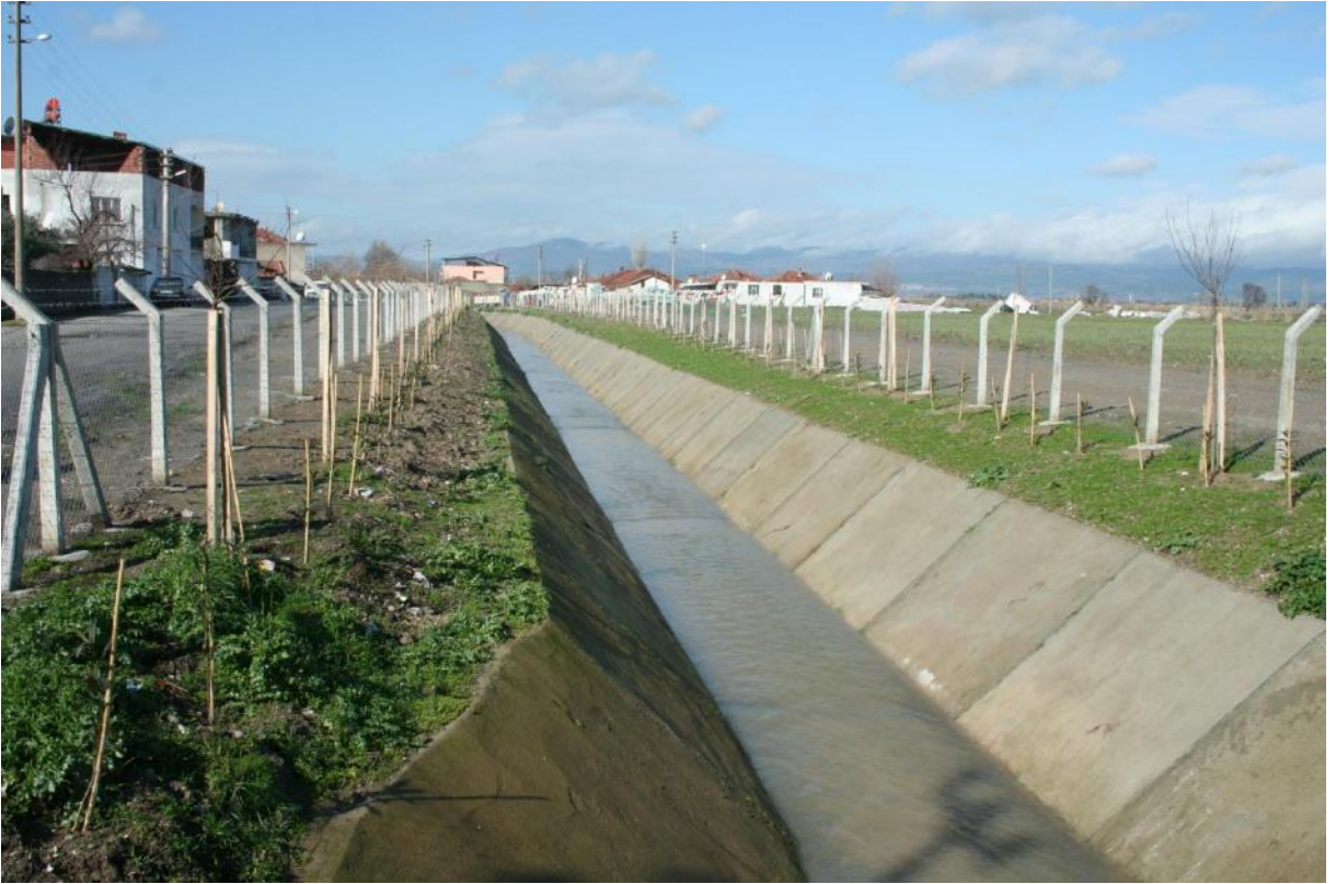
Saruhan Mahallesi T11 Tahliye Kanalı Görünüşü.
