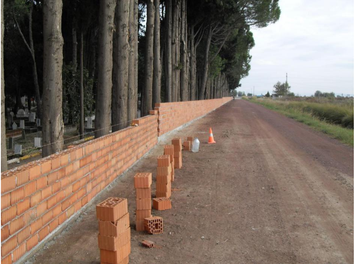
Merkez mezarlığın tahliye yolu cephesi duvar yapımı.
