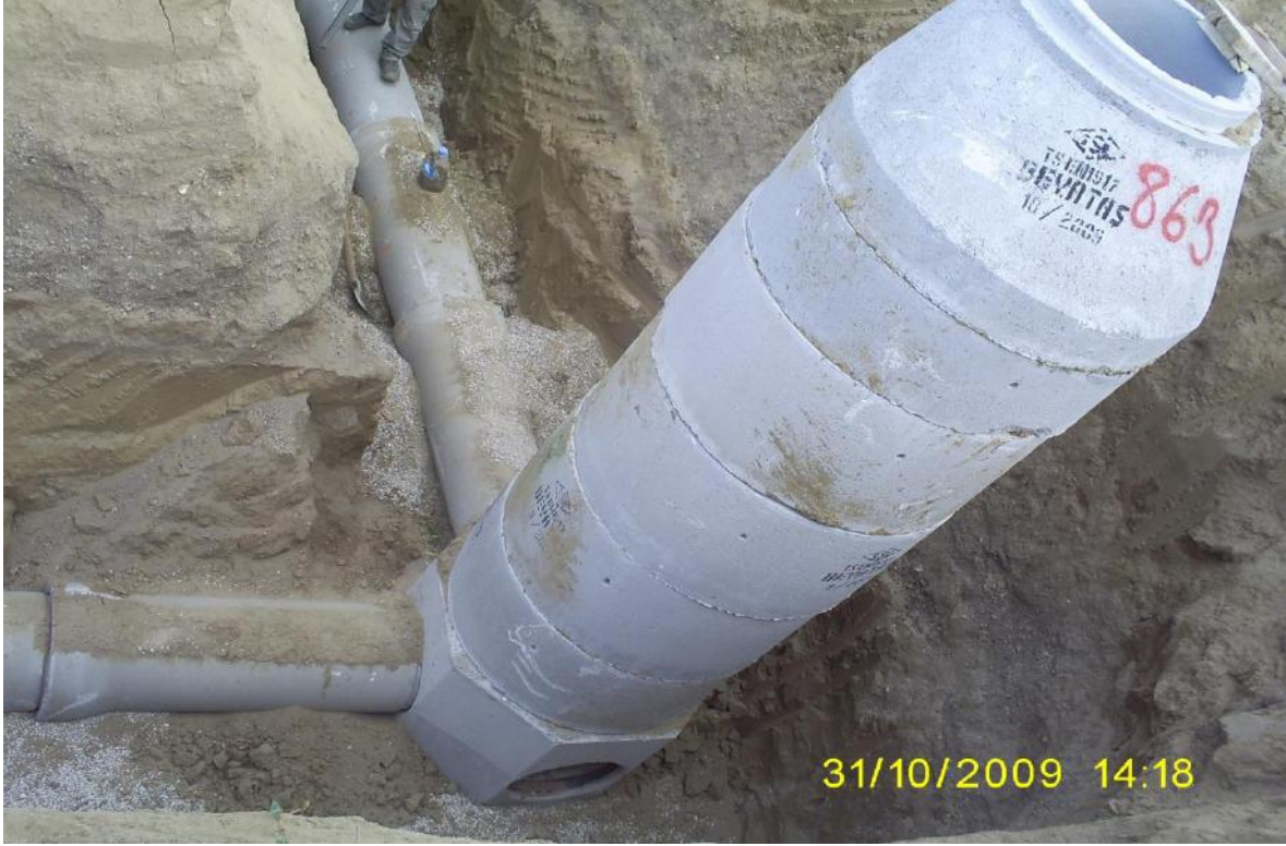
Kanalizasyon İnşaatında 863 nolu Köşe Muayene Bacası Görünüşü.
