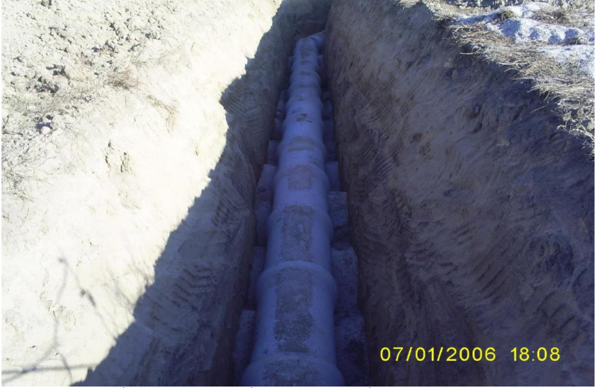
Kanalizasyon İnşaatı Ana Kolektör İnşaatında Hendek İçine Yataklamadan sonra Döşenmiş o 800 lük B.A.Entegre Contalı Beton Boru Görünüşü.
