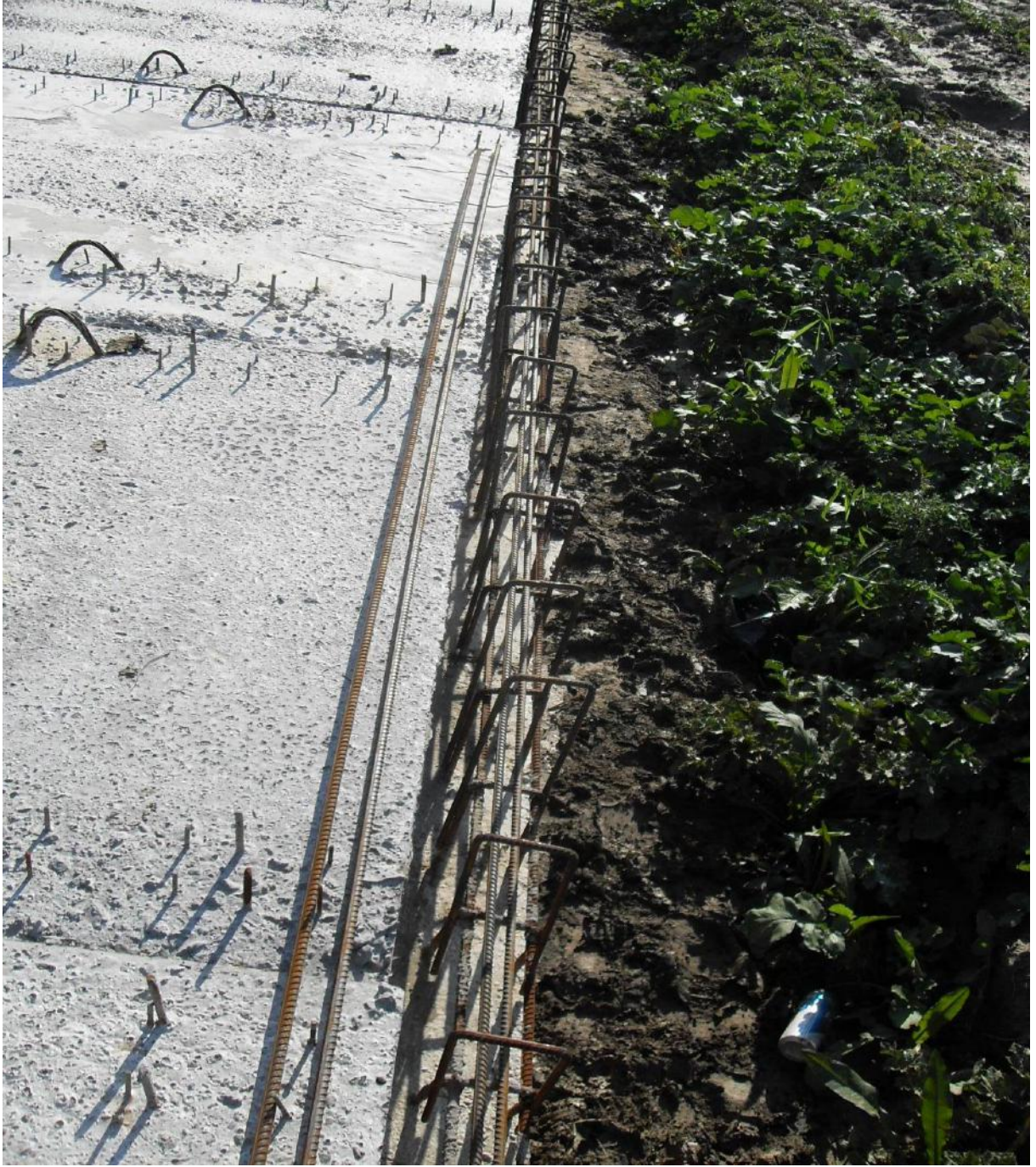
T11 Tahliye Kanalının Öngerilmeli prefabrik çift-Te eleman ile kapatılmasından sonra hatıl yapılması
