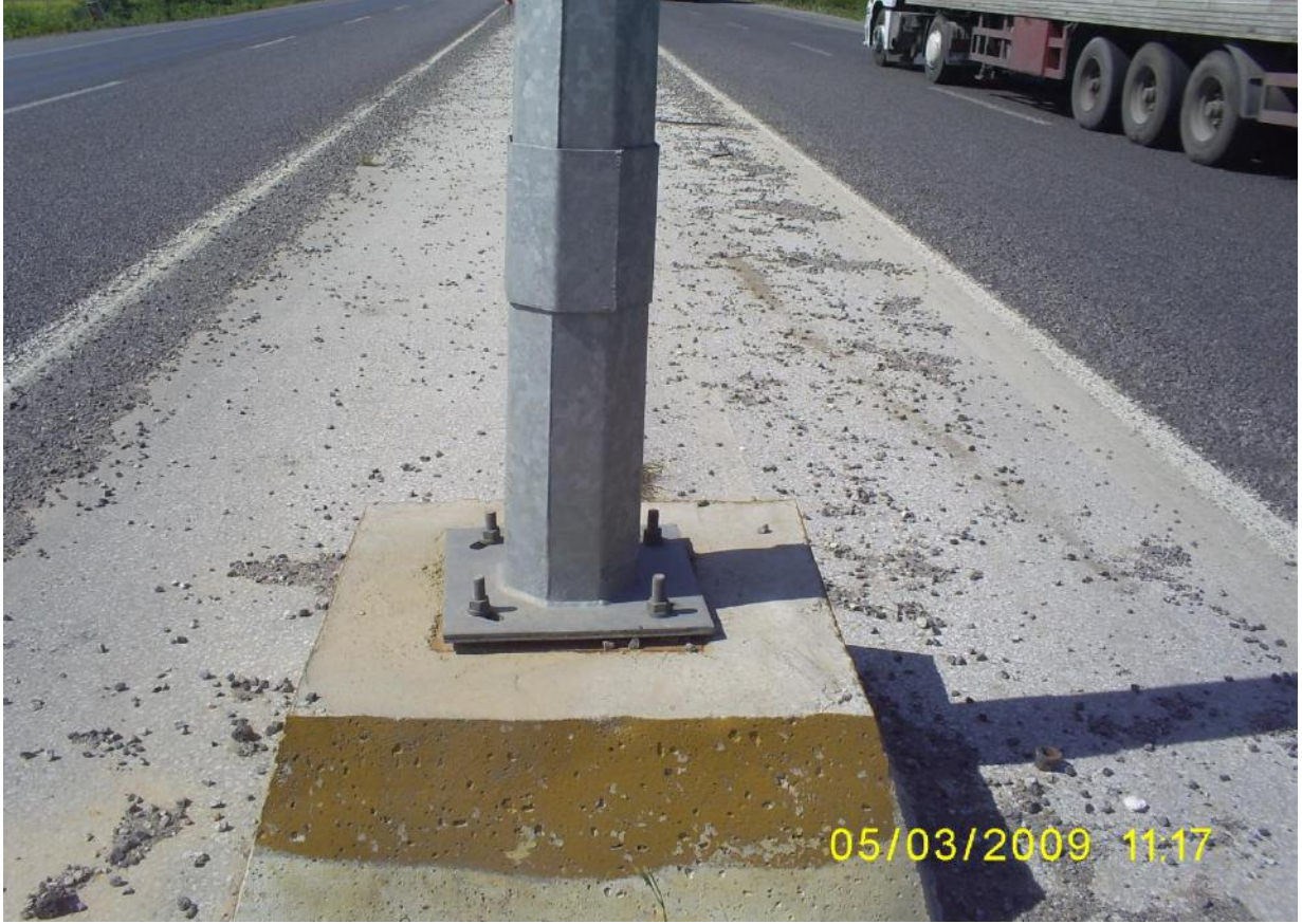
Orta Refüj Temel Direk Bağlantı Noktası Görünüşü.
