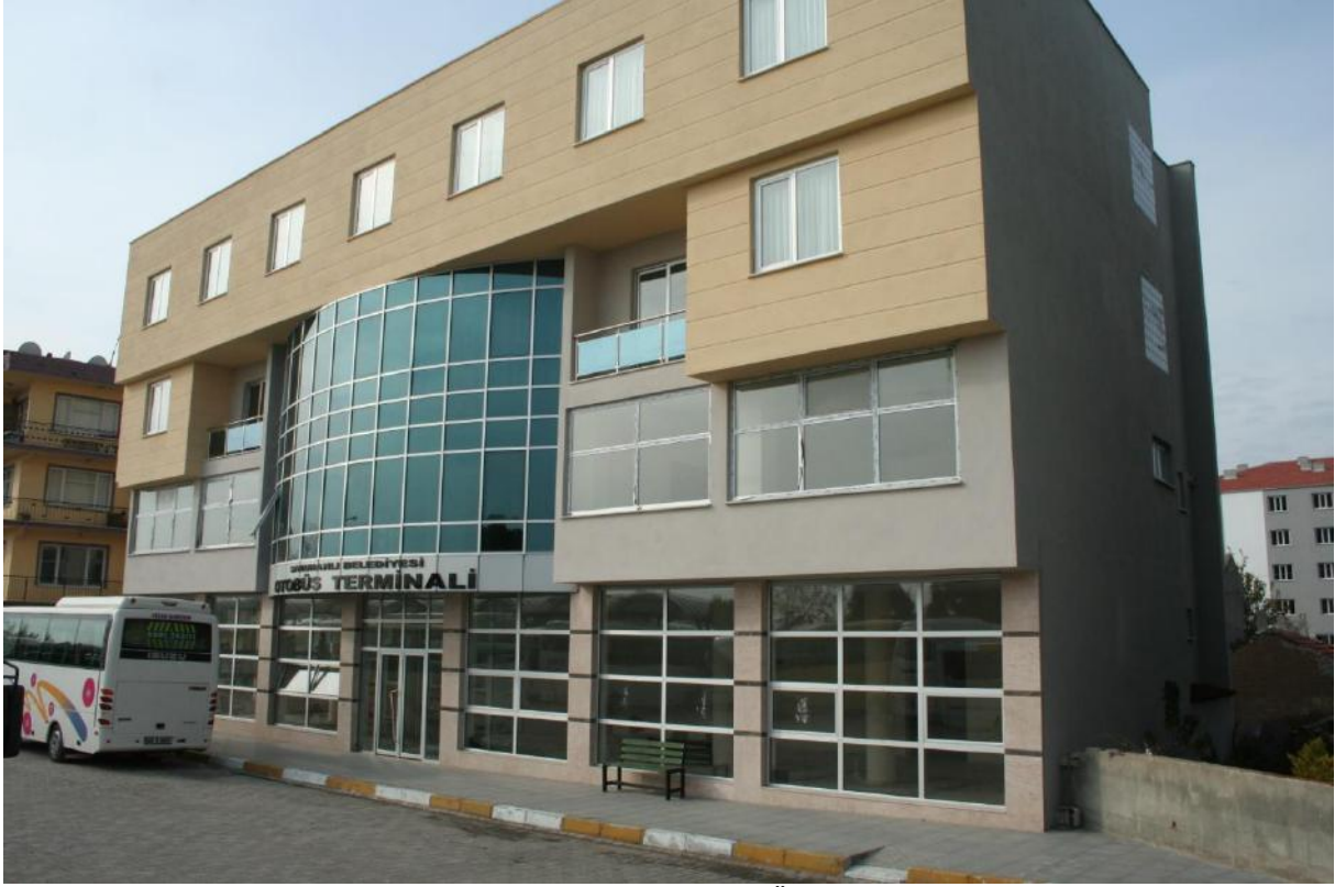
Otel ve Terminal Binasının Ön Cehesi
