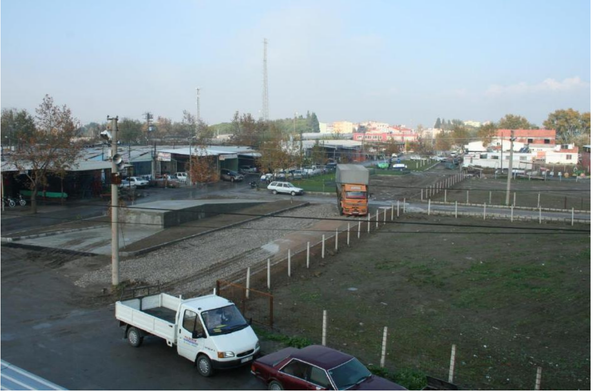
Sanayi Sitesi Çevre Düzenleme ve Rampa Yeri yapılması
