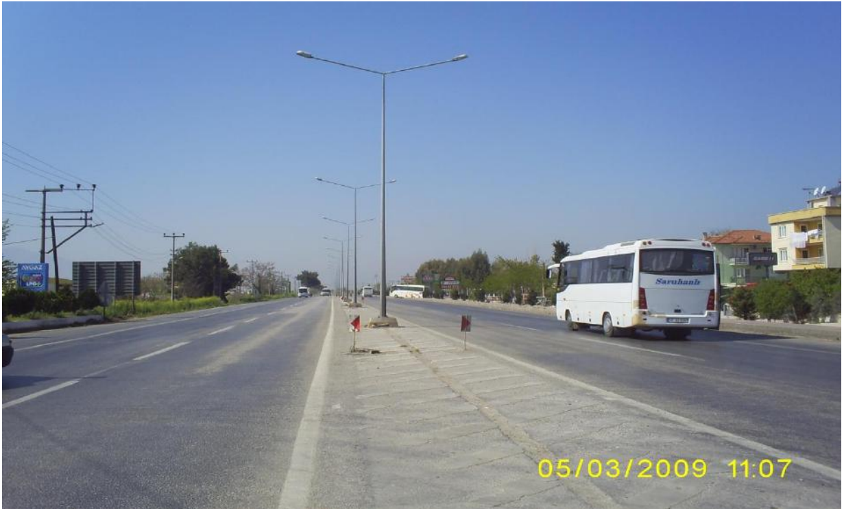
Manisa Yönünde Montajı Yapılan Direklerin Görünüşü.
