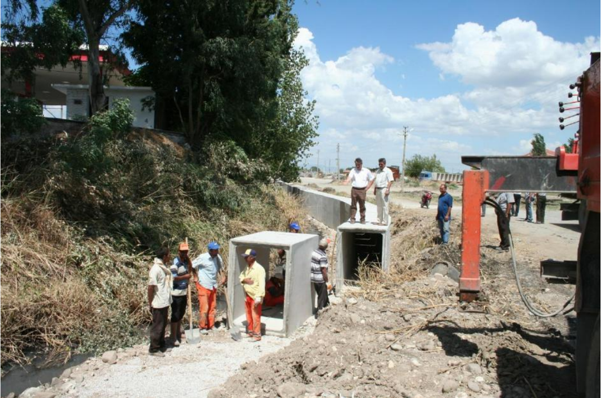
İstasyon Mahallesi İzci Petrol Arkası Tahliye kanalının baks ile kapatılması
