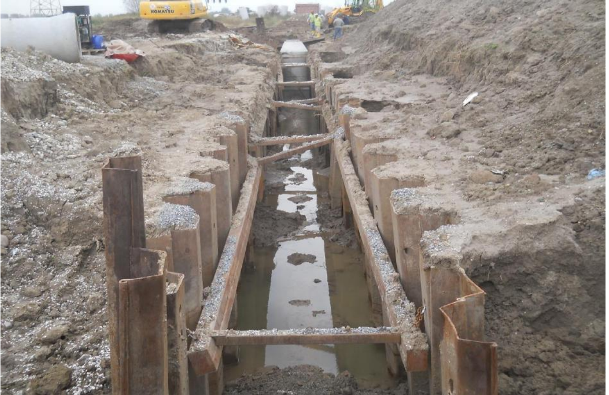
Palplanşlı çelik iksa Kazı yapımı ile 400 mm çapında boru ile kanalizasyon yapımı
