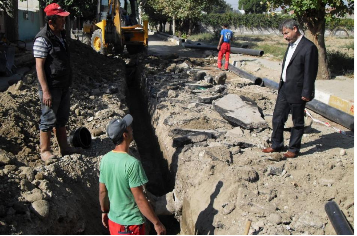
İçme suyu şebeke yenileme çalışmaları
