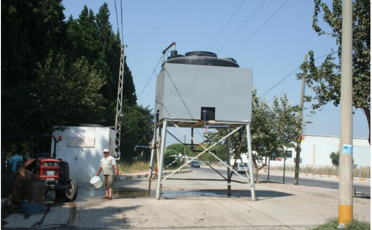
Saruhanlı Merkez Mezarlığı değiştirilen su deposu
