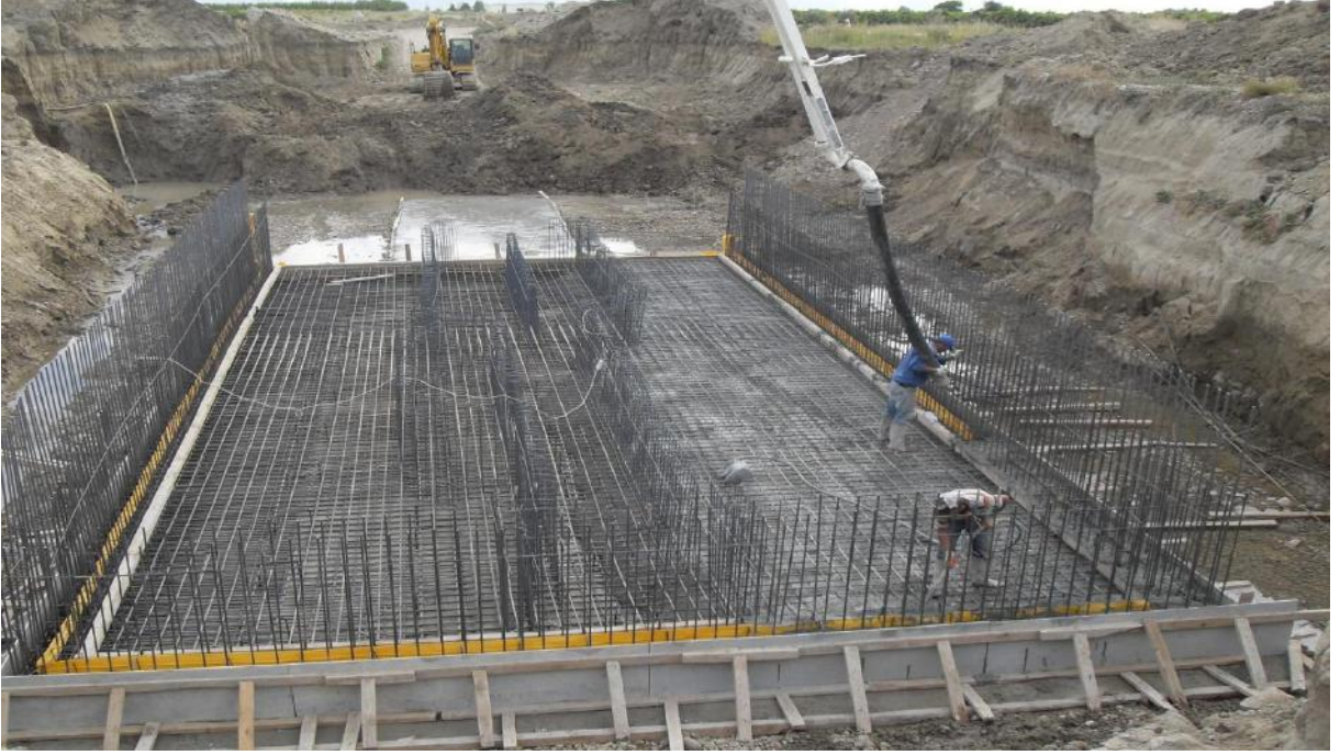
TM2 Terfi Merkezi Temel Betonu Çalışmaları
