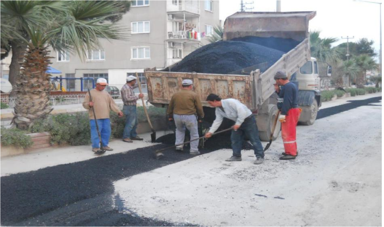
Asfalt Yama Çalışmaları
