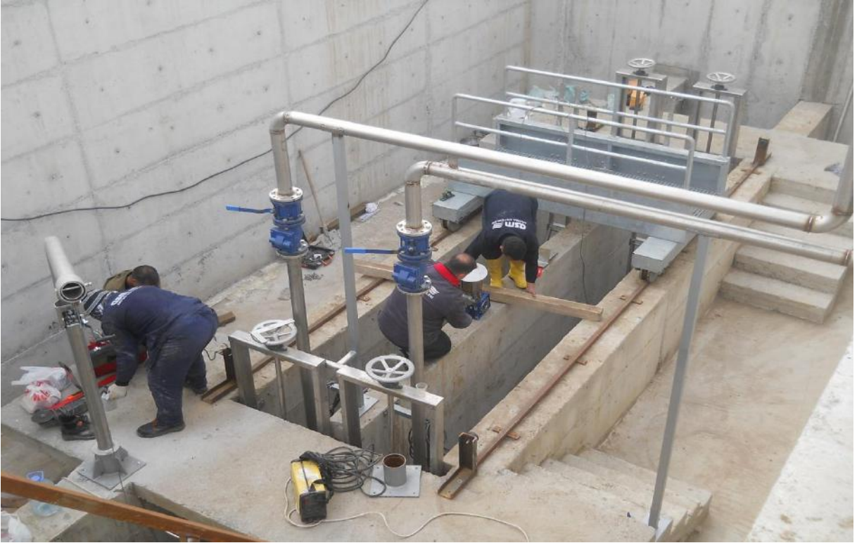
TM2 Terfi Merkezi Ekipmanları Montaj çalışmaları
