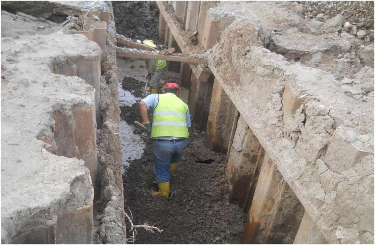
Palanşlı çelik iksa Kazı sonrası yataklama yapılması
