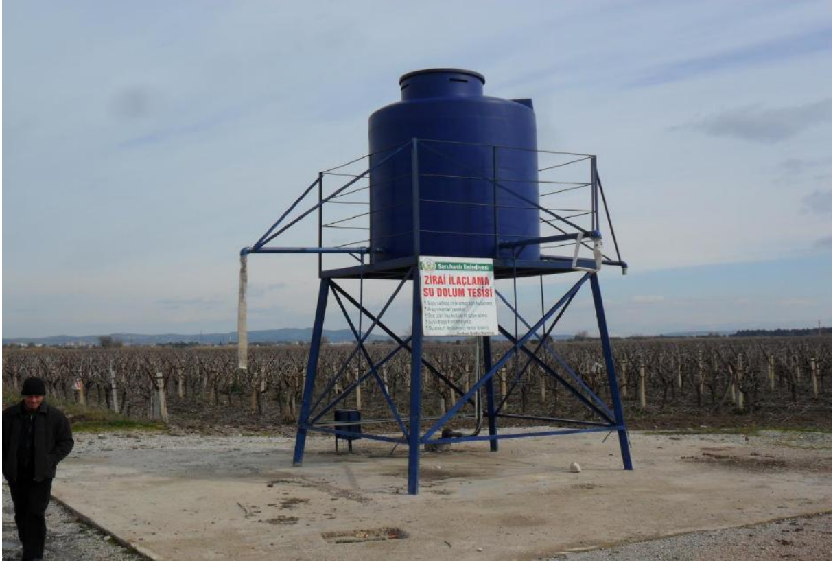
Yedek 9 Sulama Kanalı Yoluna Yeni yapılan İlaçlama amaçlı Su Deposu
