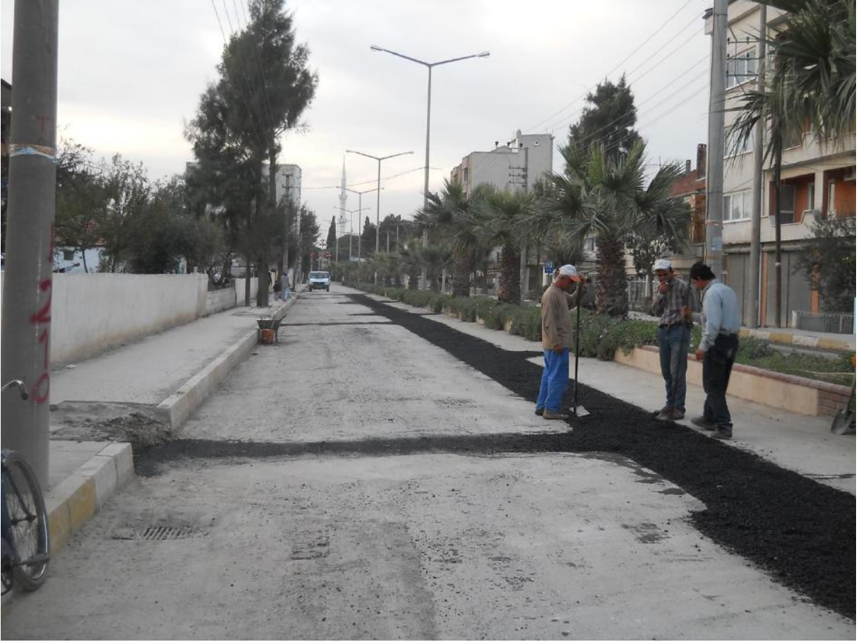
Kanalizasyon gecen yollarda yapılan Asfalt Yama Çalışmaları
