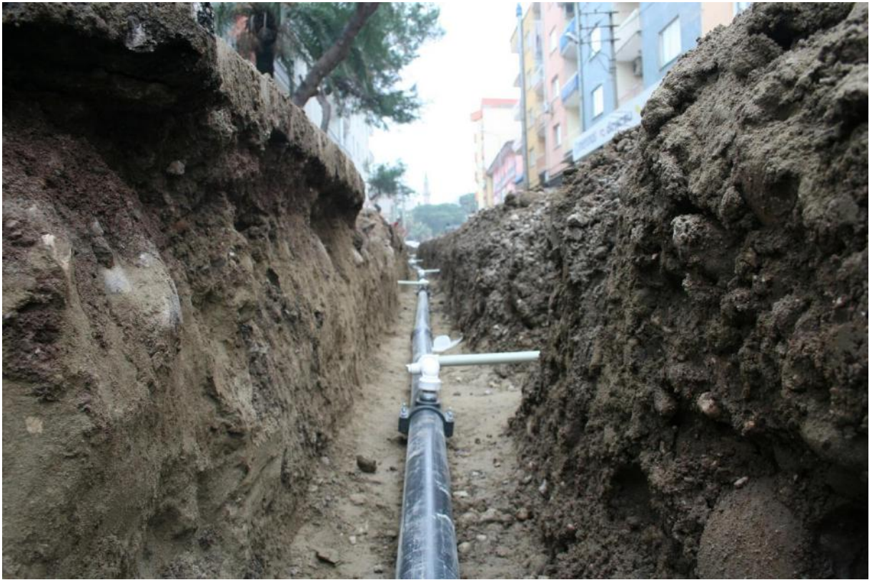
İçme suyu Őebeke yenileme çalışmalarını
