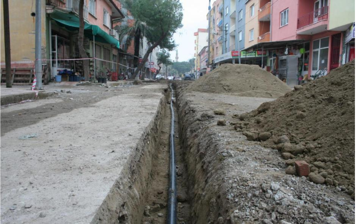
İçme suyu şebeke yenileme çalışmaları
