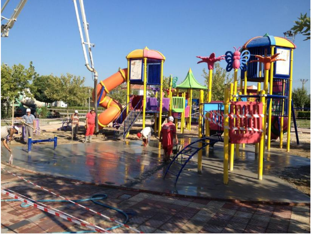
Kauçuk kaplanacak alanlara perdahlı beton atılma çalışması
