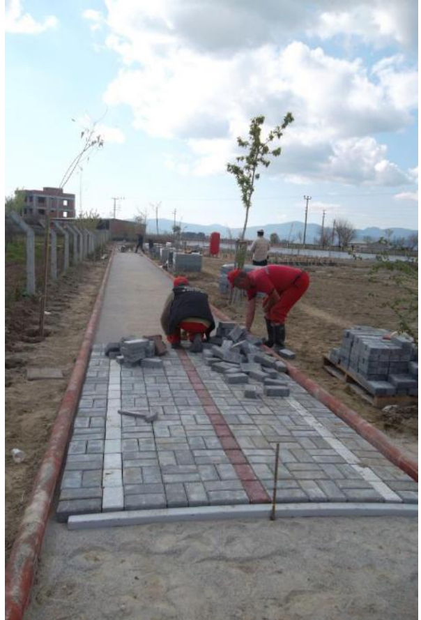
Yürüme parkuru döşeme çalışması
