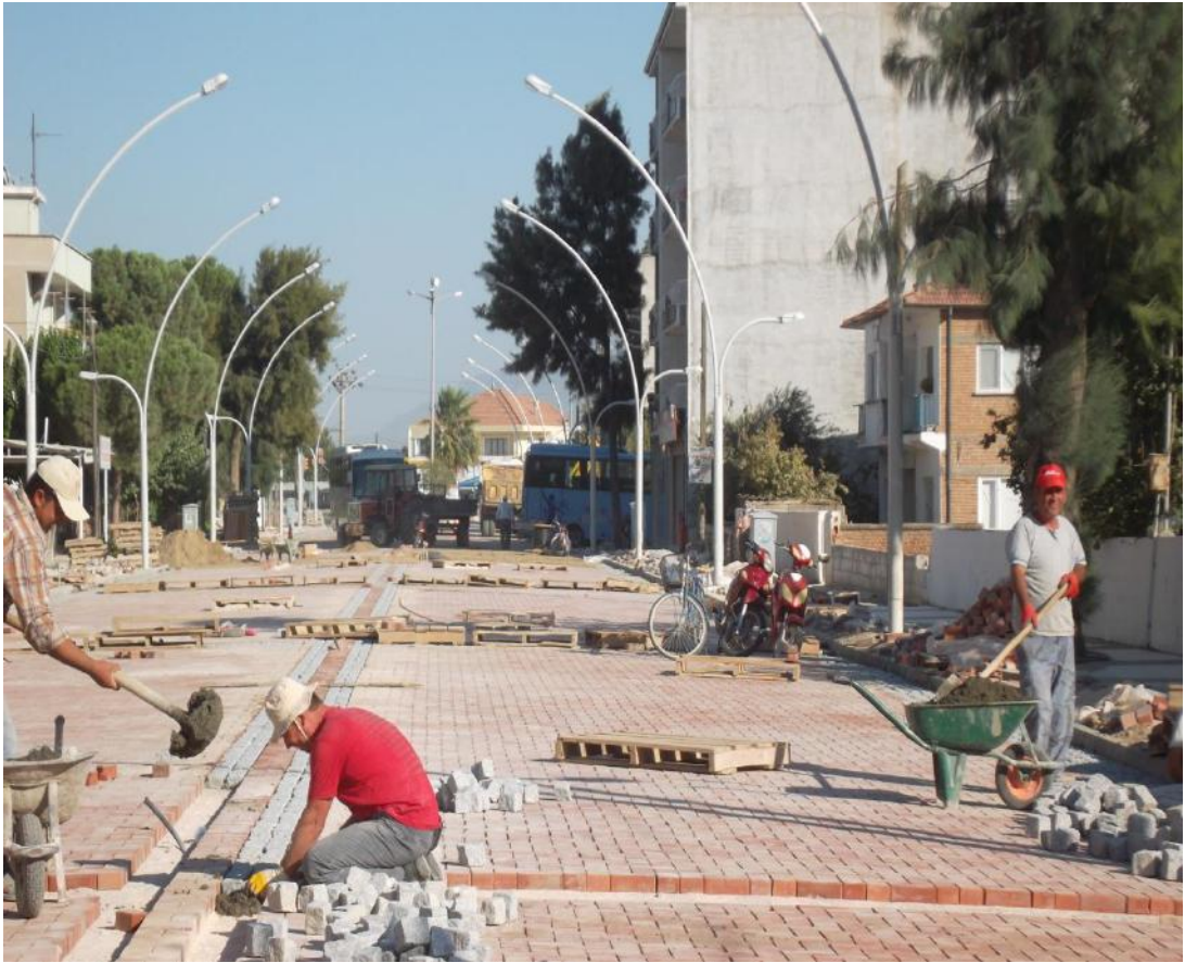
Yol döşeme çalışmaları
