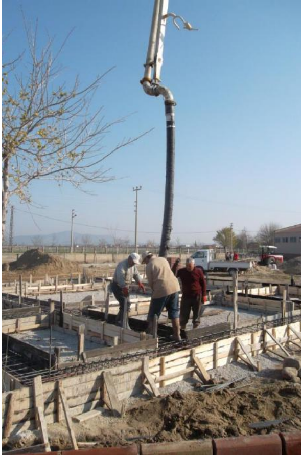
Kafeterya binası temel inşaatı
