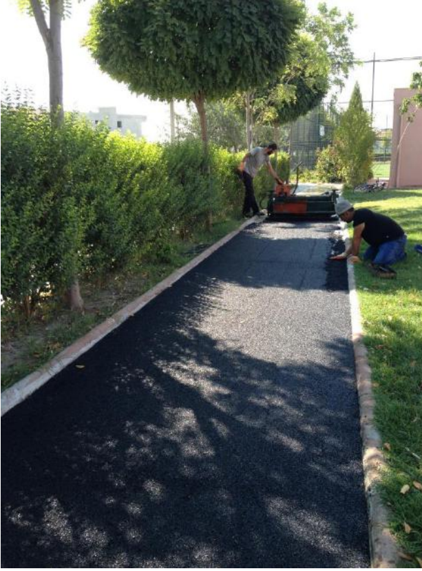
Koşu ve yürüyüş parkuruna SBR ve EPDM kauçuk kaplama çalışmaları
