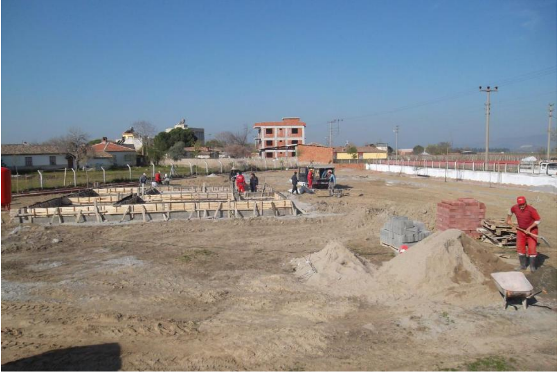
Kafeterya binası temel-subasman inşaatı sırasında çalışma alanı.
