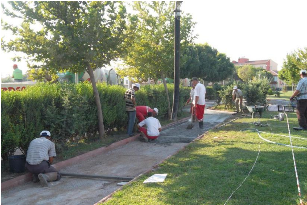
Kauçuk kaplanacak alanlara perdahlı beton atılma çalışması
