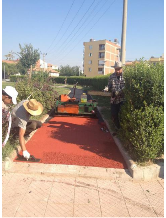
Koşu ve yürüyüş parkuruna SBR ve EPDM kauçuk kaplama çalışmaları
