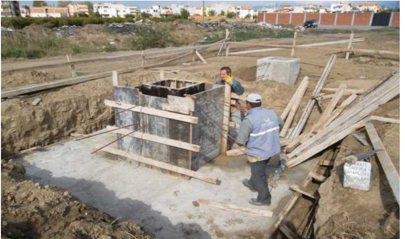
Temel soketlerinin yapılması
