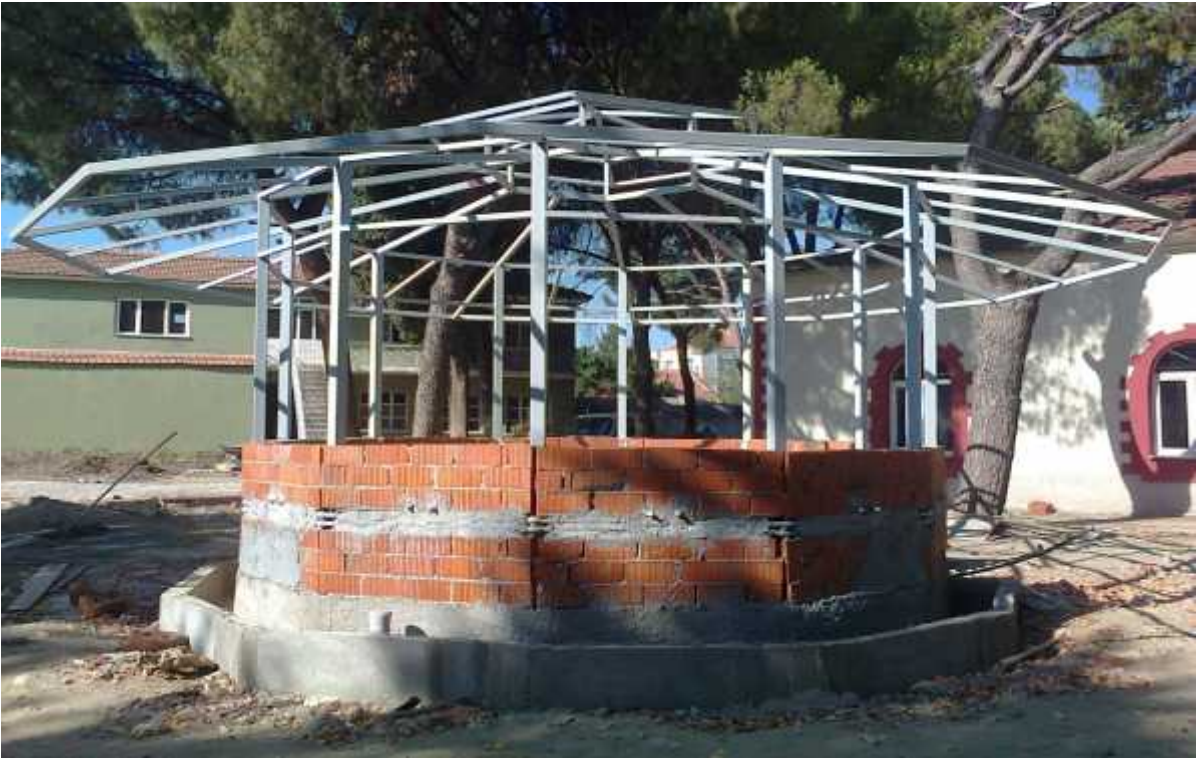
- adırvana ait çatının ta ıyıcı sisteminin olu turulması
