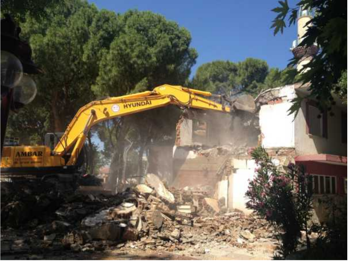
-Eski tuvalet ve adırvan binasının yıkımı
