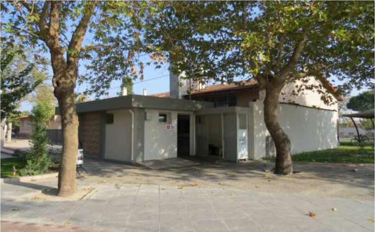
-Yeni tuvalet binası
