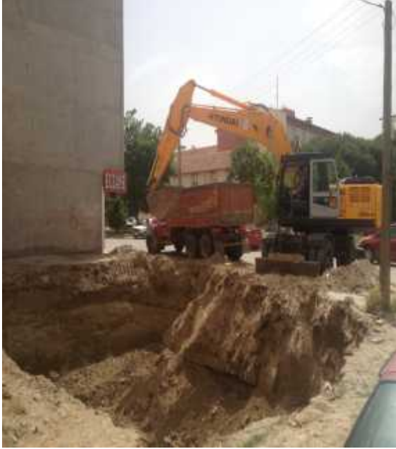
Temel Kazı Çalışmaları
