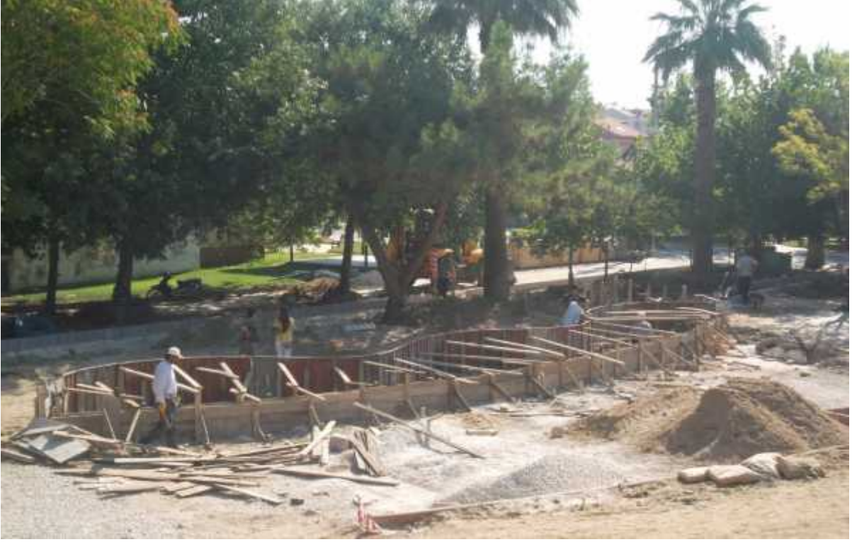
-Havuz kalıbının çakılması
