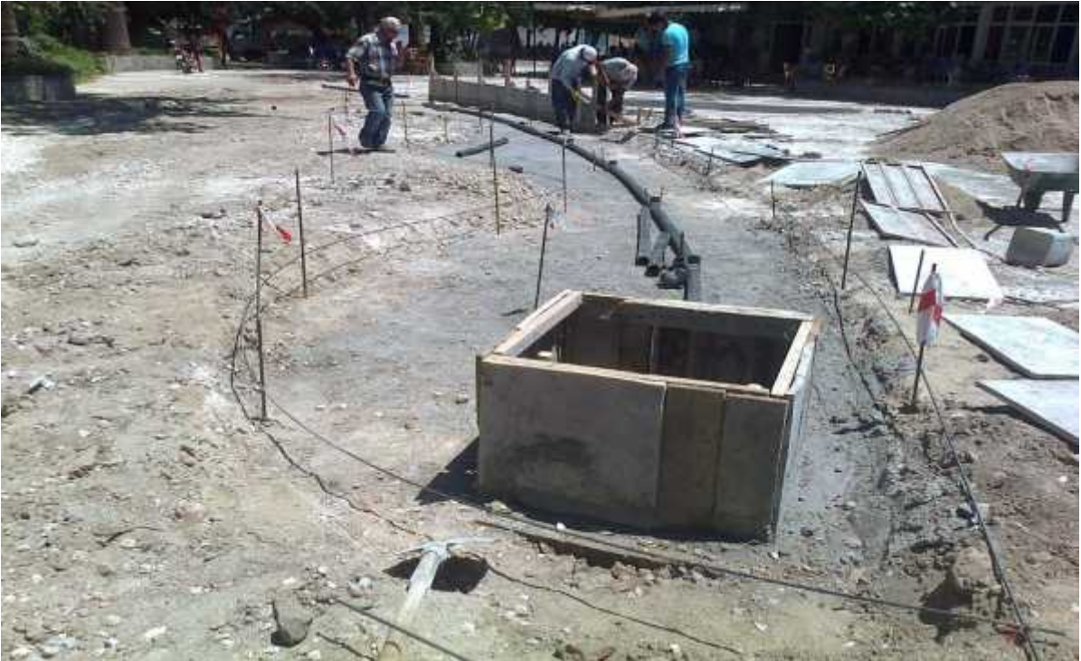
-Havuz tesisatının dö enmesi
