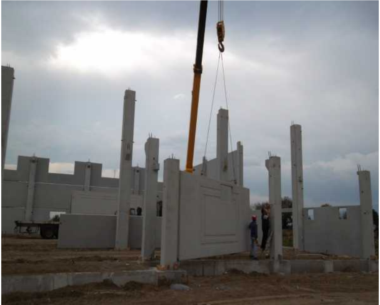
PREFABRİK KOLON-DUVAR PANELLERİNİN MONTAJLARININ YAPILMASI
