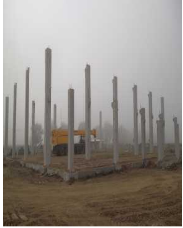
PREFABRİK KOLON-DUVAR PANELLERİNİN MONTAJLARININ YAPILMASI
