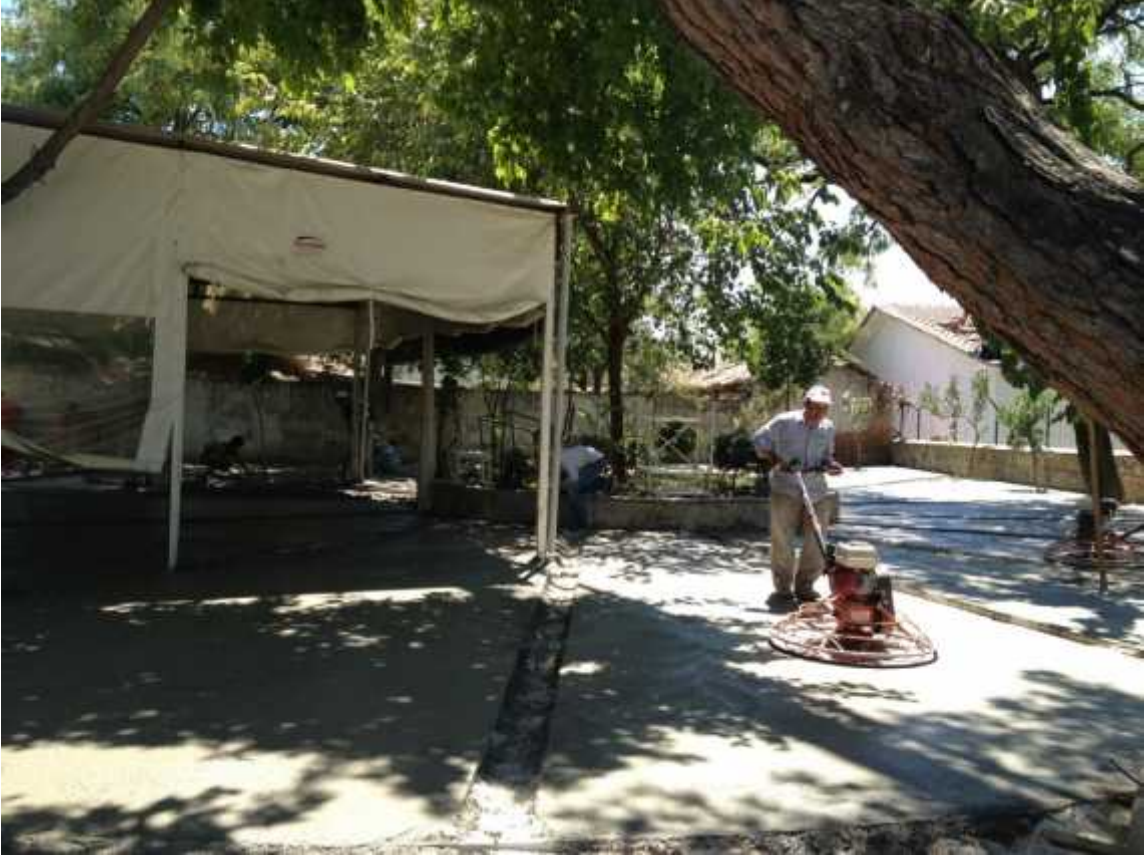
-Pervane perdahlı beton atılması
