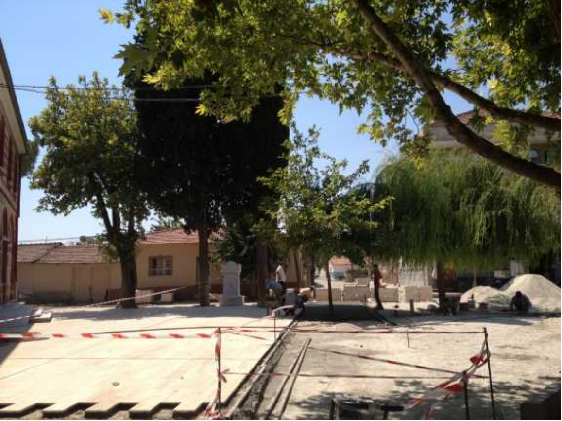
-Camii önü traverten döeme çalışmaları
