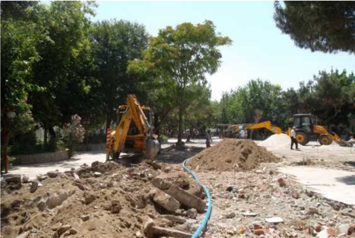
-Yılmaz meydanı- adırvan ve süs havuzuna su tesisatının çekilmesi çalı maları
