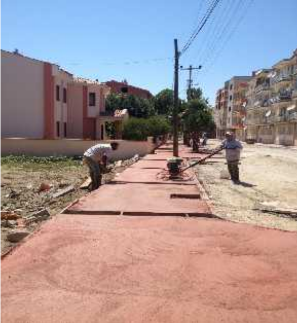
Pervane perdahlı beton uygulaması
