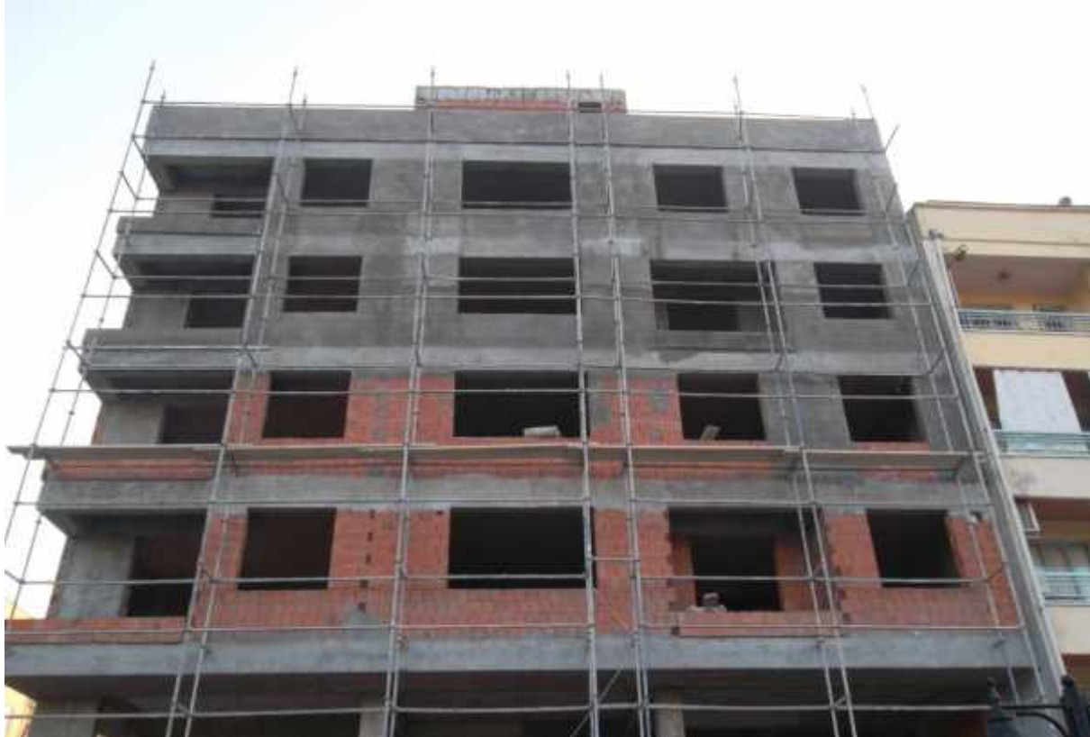
Dış Sıva Yapılması
