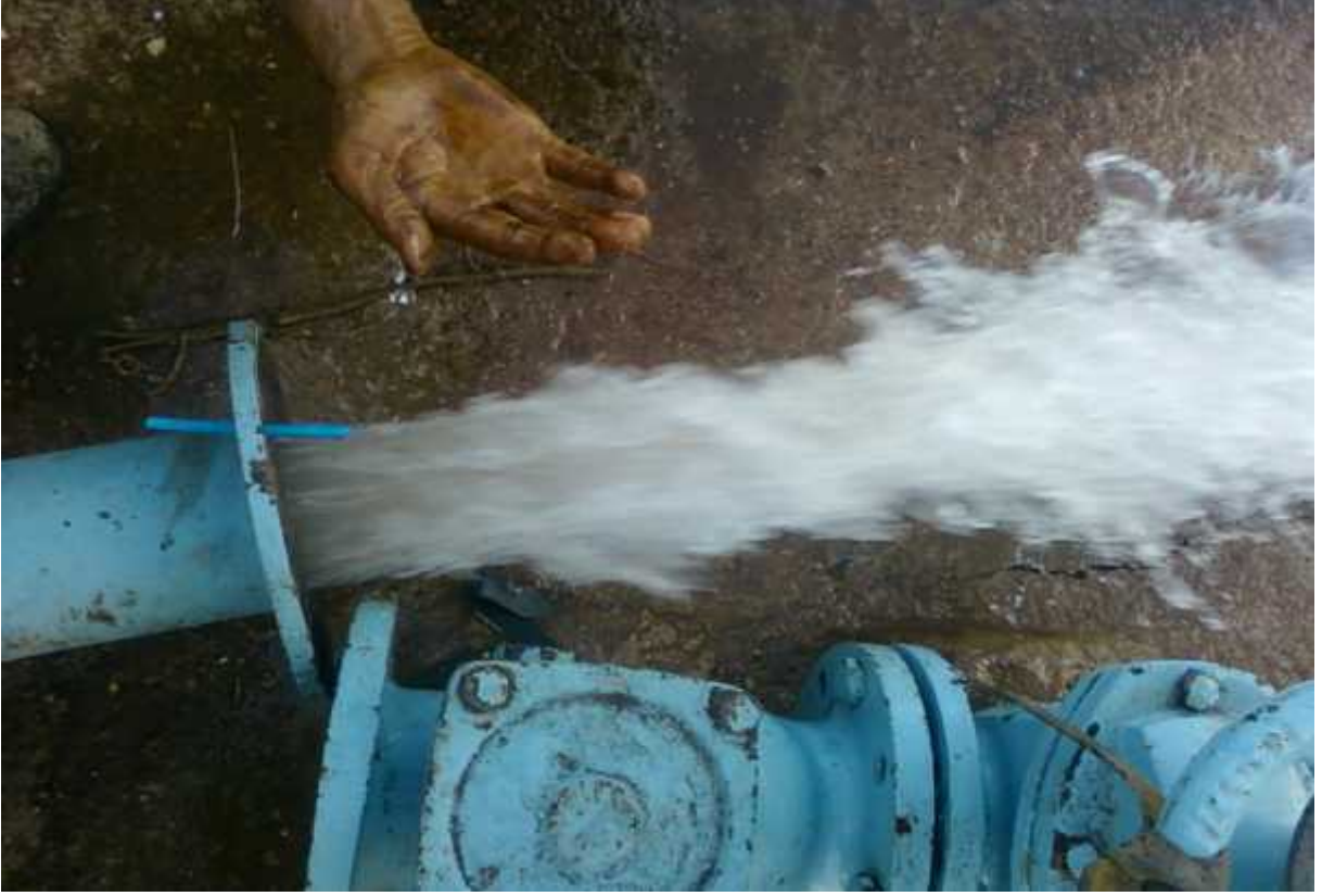
Kırlarda Yeni Açılan Kuyunun ebekeye Bağlantısı
