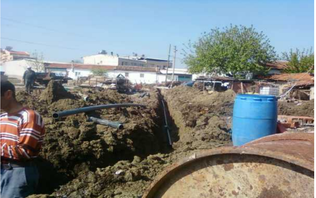
Su ebesesi Yenileme Çalışmaları
