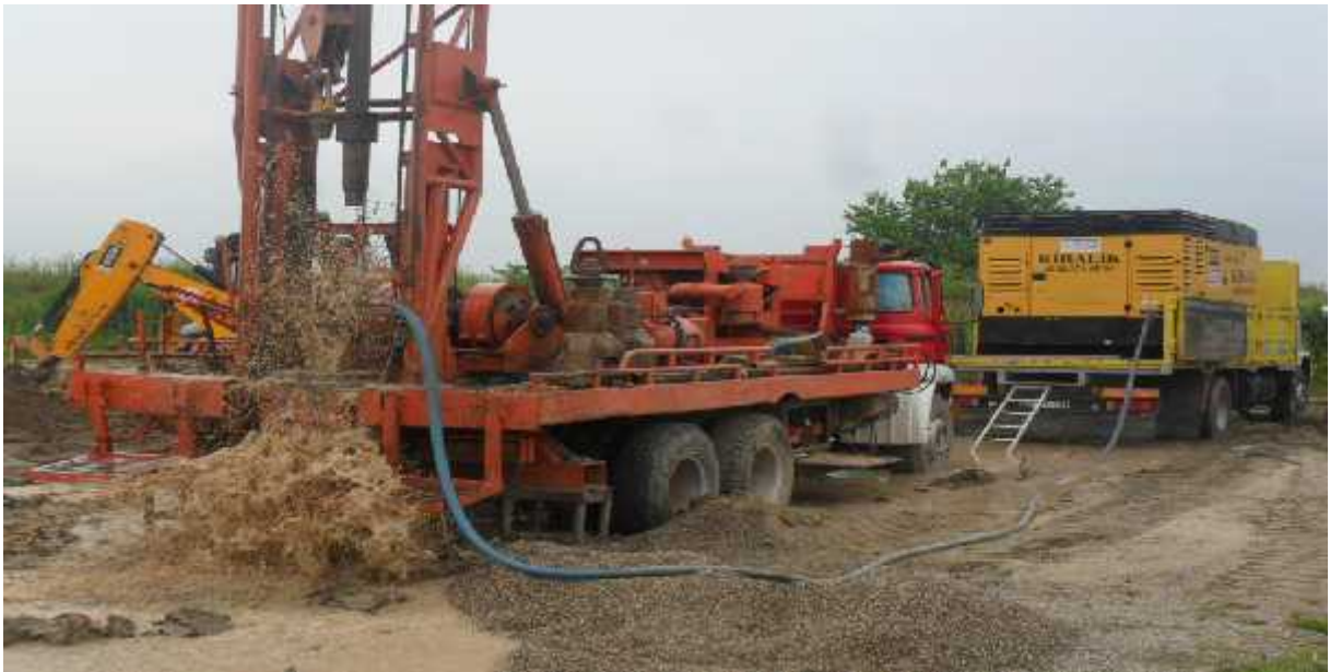
( L4 ) İçme Suyu Kuyusu Kuyu Temizleme Çalıřmaları.
