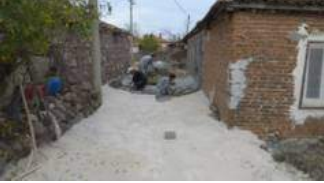
-Çaltepe Mahallesi Taş Kaplama Çalışmaları-
