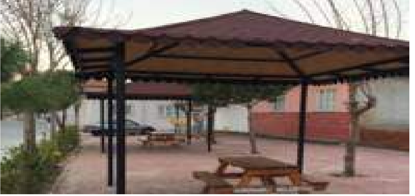
Şehitler Mahallesi Yiğit Sokak Park alanı çalışması.
