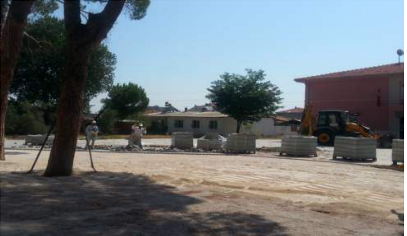
İshakçelebi Şehit Hüseyin Koşar İlkokulu bahçesine kilitli parke taşı döşeme çalışması.
