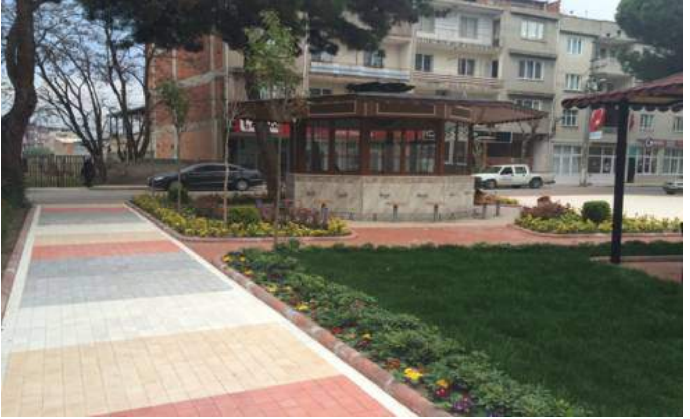
İstasyon Mahallesi Camii bahçesinde peyzaj çalışması sonrası
