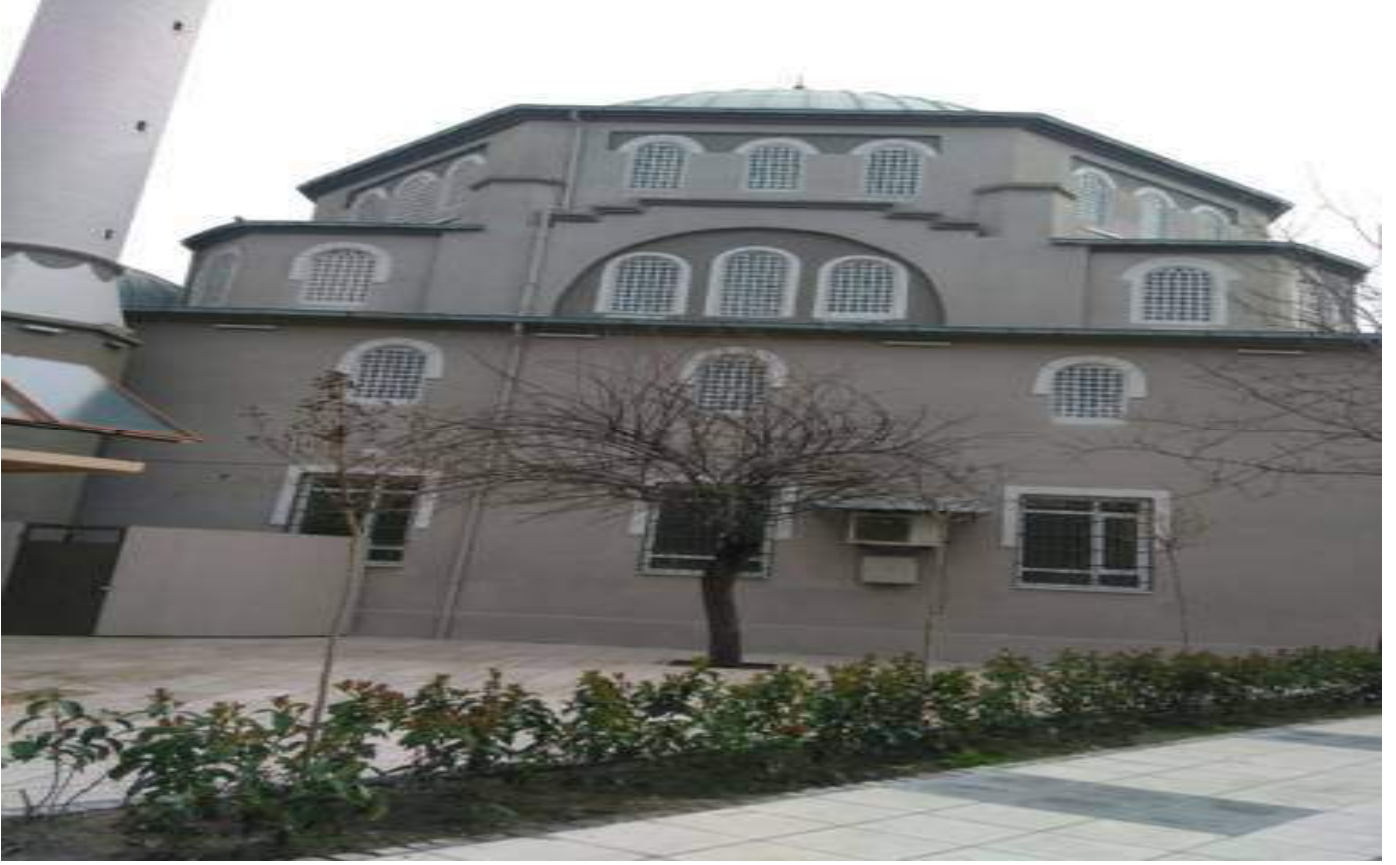
Çarşı camii dış cephe yeni hali
