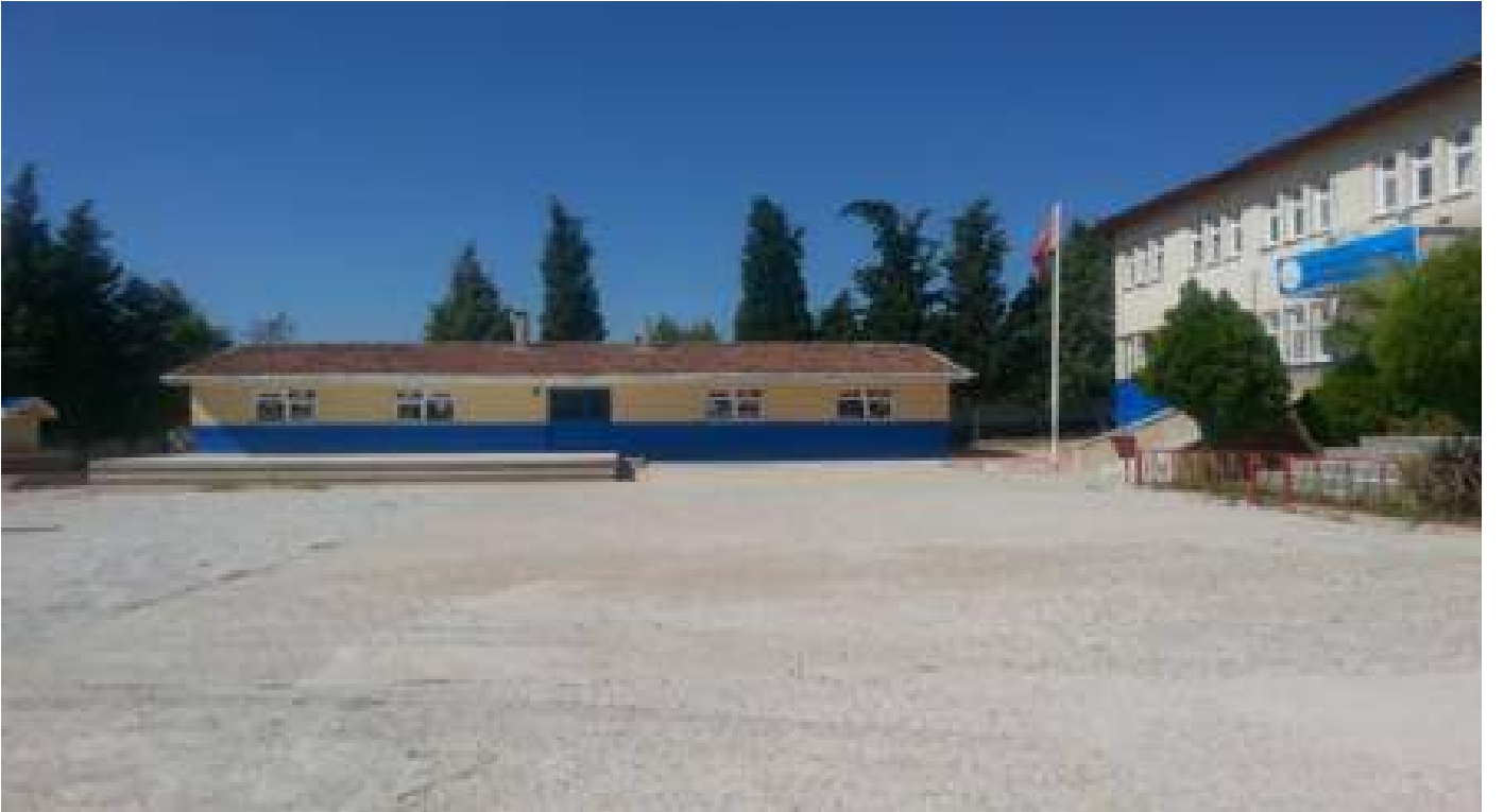
Dilek Şehit Emrah AKMAN İlköğretim Okulu Eski Hali
