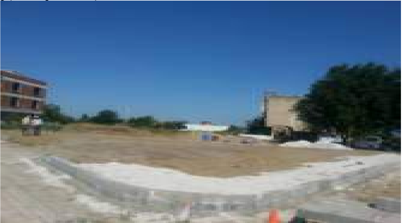
İstasyon Mahallesi Levent Sokak park alanı çalışması öncesi
