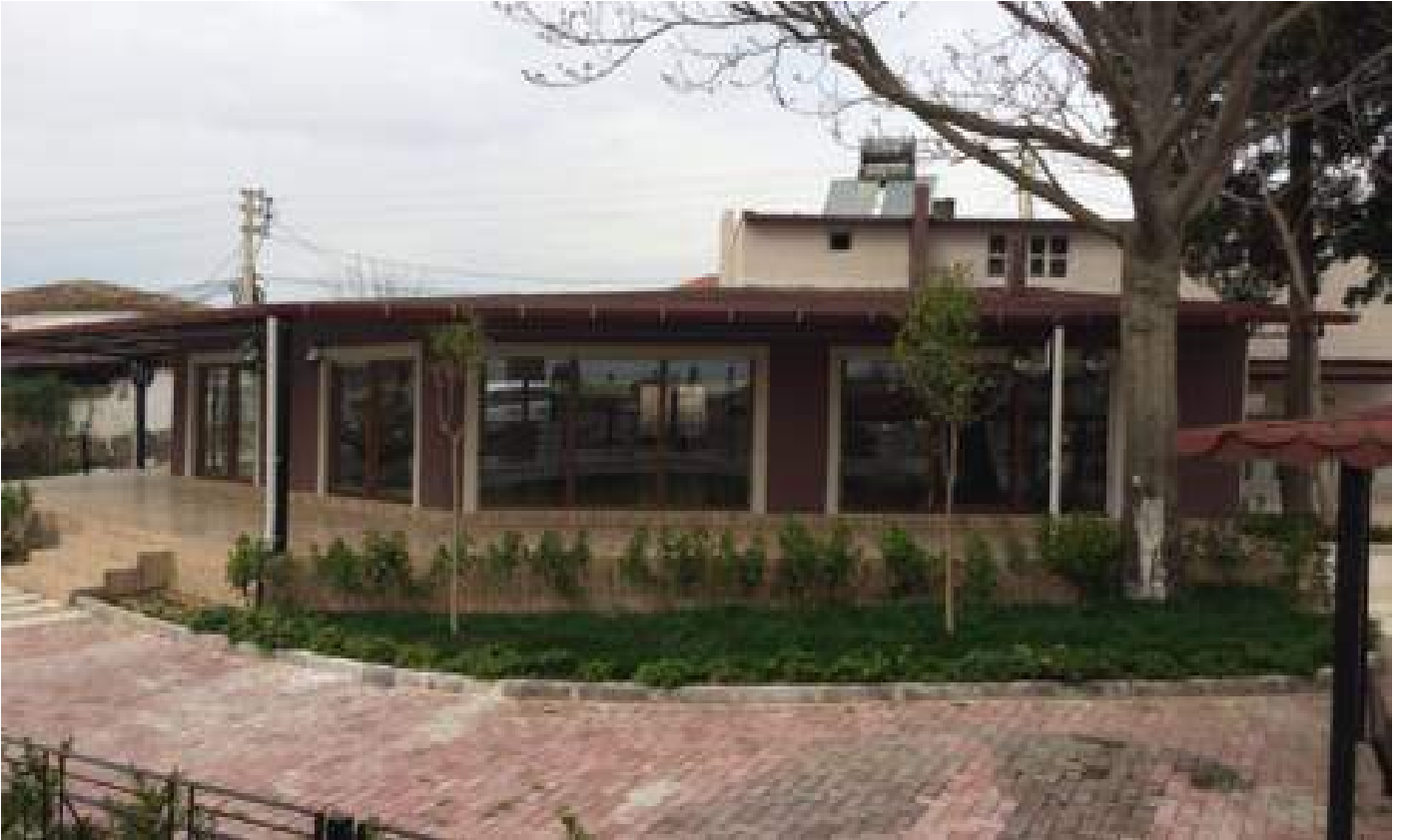
Gümülceli Mahallesi Sosyal Tesislerin yeni hali dış görünüşü.
