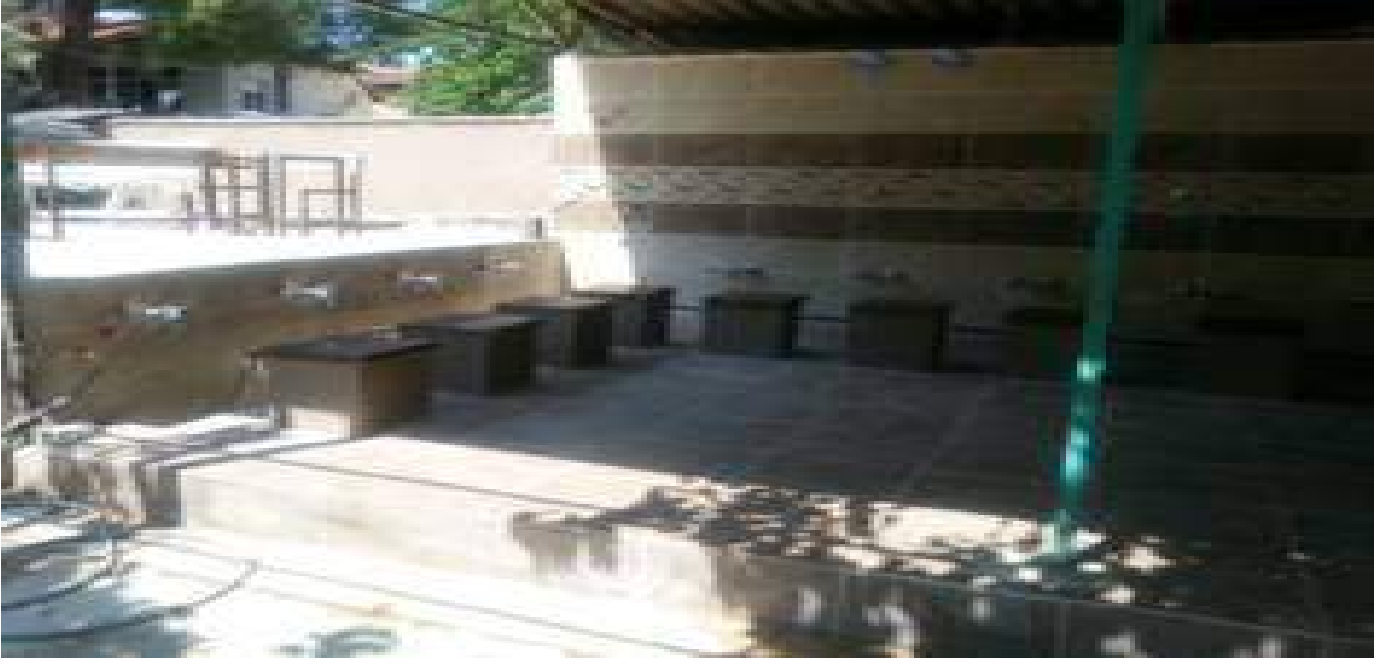
Gökçe Mahallesi Camii şadırvan yeni hali
