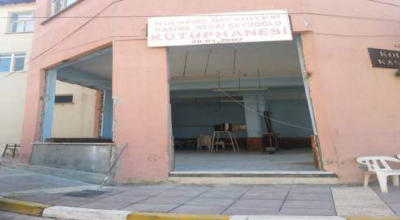
Koldere Mahallesi Belediyeye Ait Binanın Eski Görünümü
