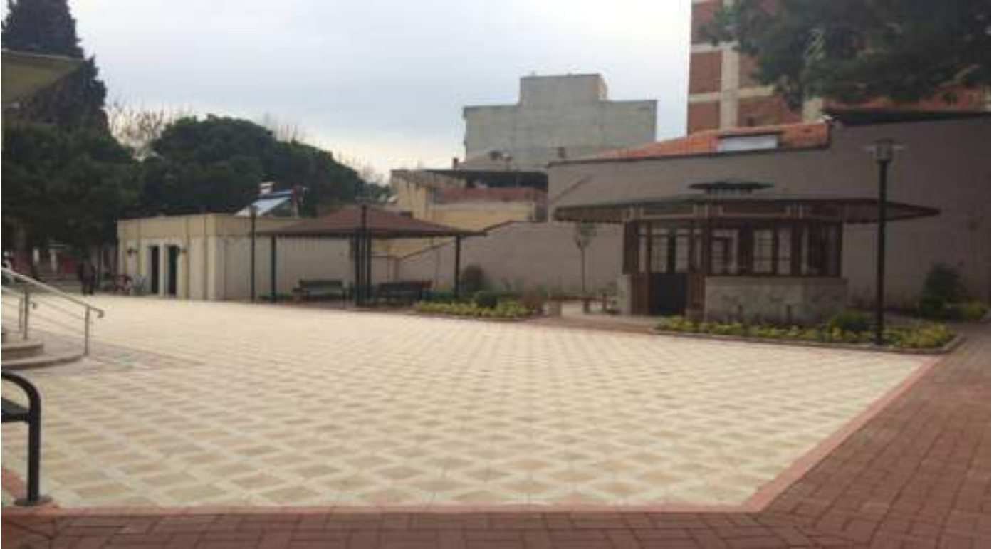
İstasyon Mahallesi Camii bahçesinde peyzaj çalışması sonrası
