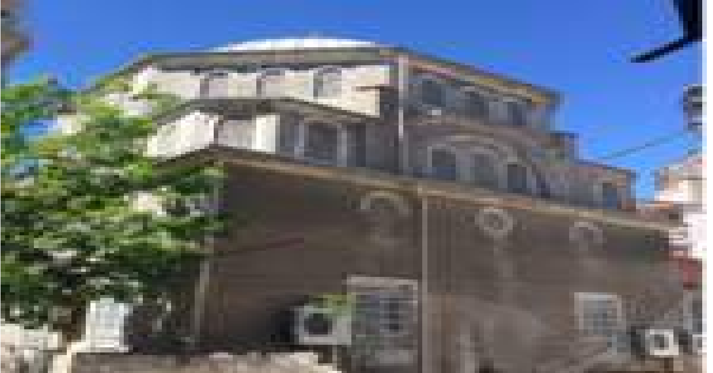
Çarşı camii dış cephe eski hali
