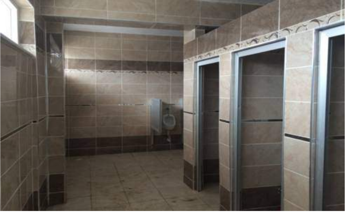
Mütevelli mahallesinde bulunan pasaj tuvaletlerinin yenilenmesi
