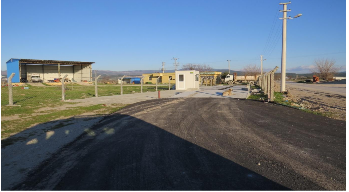
Paşaköy Mahallesi 60 tonluk kantarın kurulumundan sonraki görünümü
