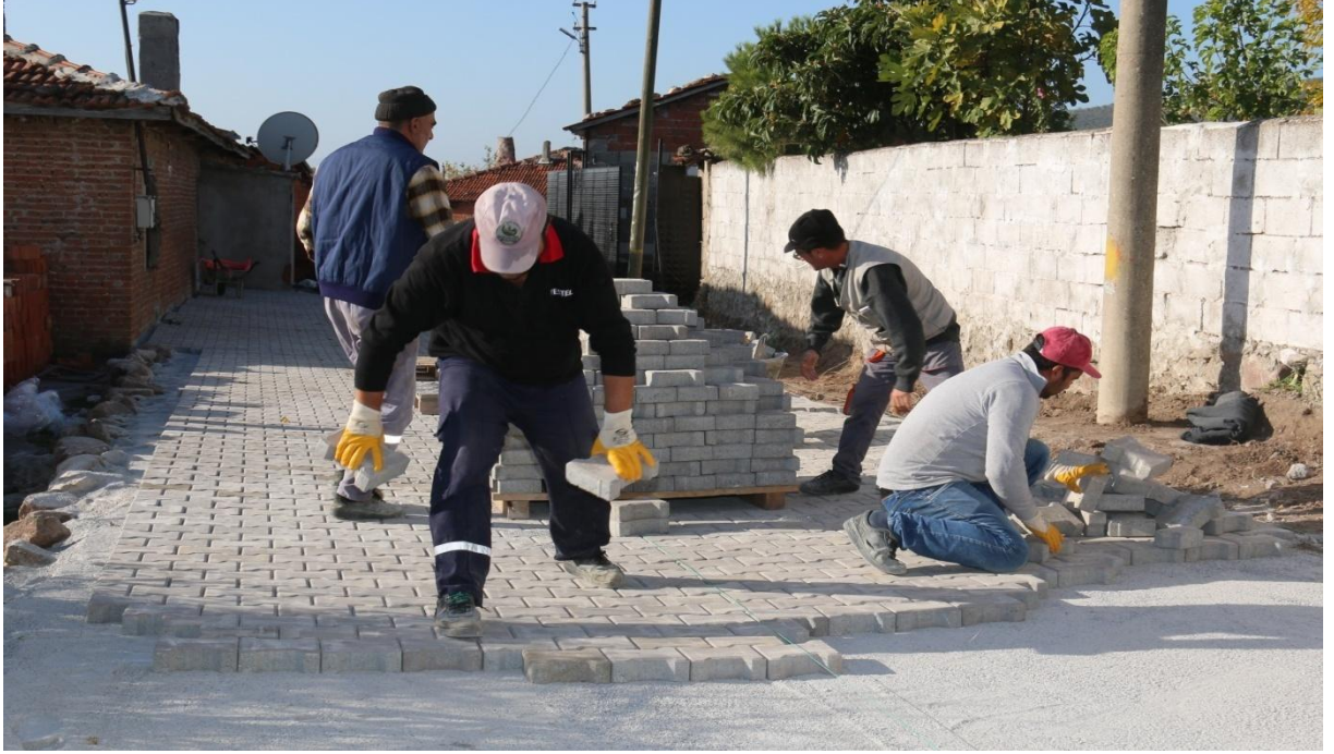
Çaltepe Mahallesi taş döşeme çalışmaları
