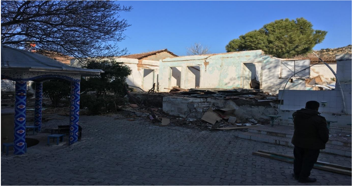
Çullugörece Mahallesi Camii çalışmalarının başlanılmasının ardından görünüm
