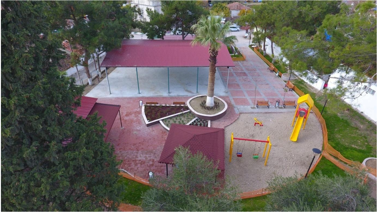
Kepenekli Mahallesi çalışmaların tamamlanmasının ardından görünümü
