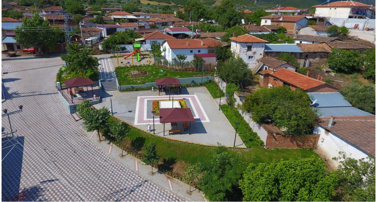
Heybeli Mahallesi meydan çalışmalarının tamamlanmasından sonraki görünümü
