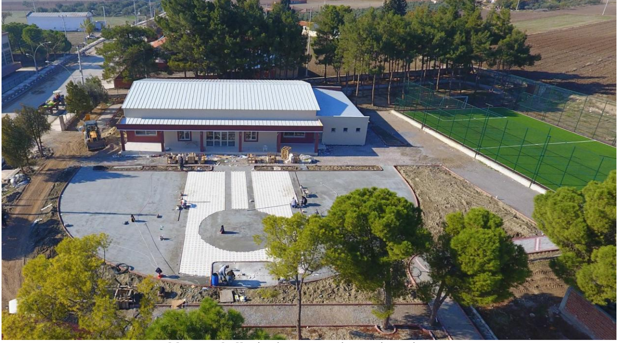
Koldere Mahallesi rekreasyon alanı çalışmalarının görünümü
